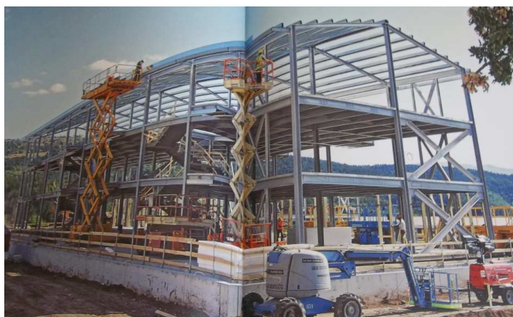
Strutture in carpenteria metallica a travi e pilastri con controventi. Serraggio in opera dei bulloni con l'ausilio di piattaforme aeree e pantografo.
