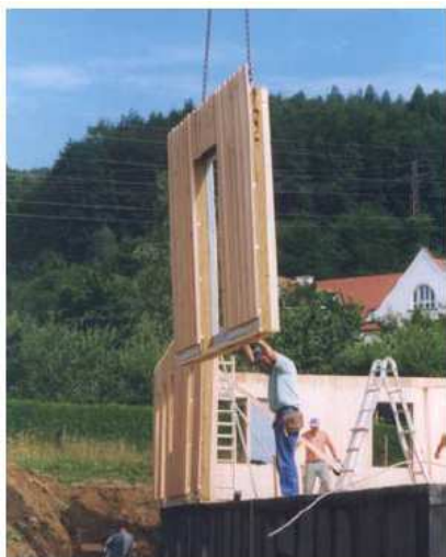
Montaggio di un elemento preassemblato (sinistra) e fissaggio di elementi di isolamento e di facciata (destra).
