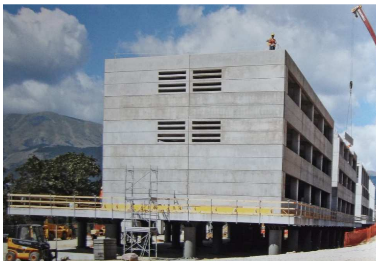
Montaggio dei pannelli esterni prefabbricati in calcestruzzo a nastro orizzontale.
