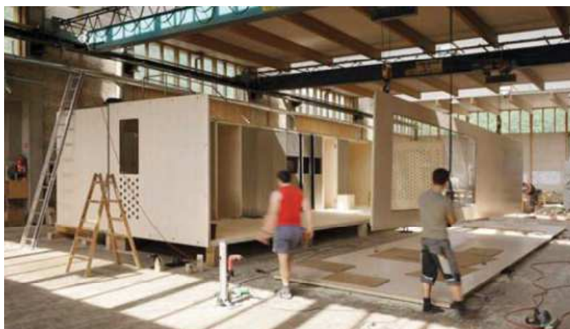
Realizzazione in stabilimento di moduli abitativi prefiniti.
