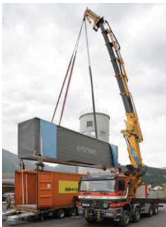
Sollevamento e trasporto di un modulo abitativo prefabbricato.
