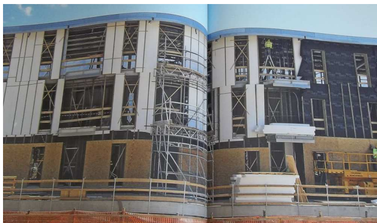
Montaggio a secco di tamponamenti perimetrali.
