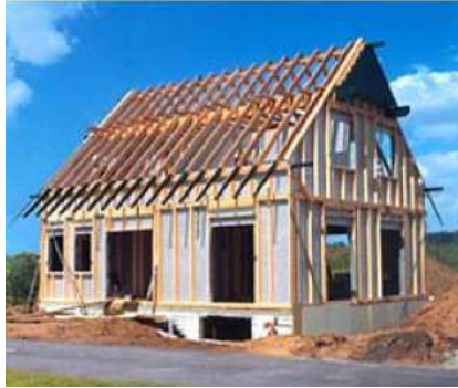
Sistema a telaio.
