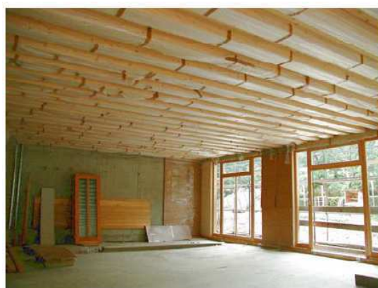
Pannello di compensato di tavole con nervature di lamellare incollato e variante a sezione a cassone.
