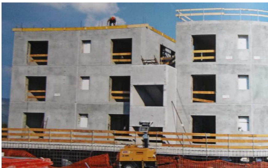
Edificio con struttura in c.a. a pannelli portanti prefabbricati a taglio termico; i vani scale e rampe sono interamente prefabbricati.
