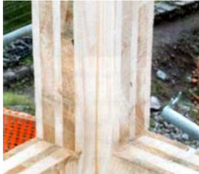
Sistema a pannelli di legno massiccio.
