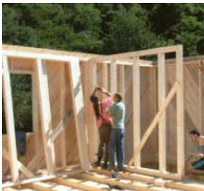
Sistema ad ossatura.
