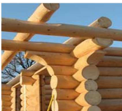
Sistema a blocchi massicci.
