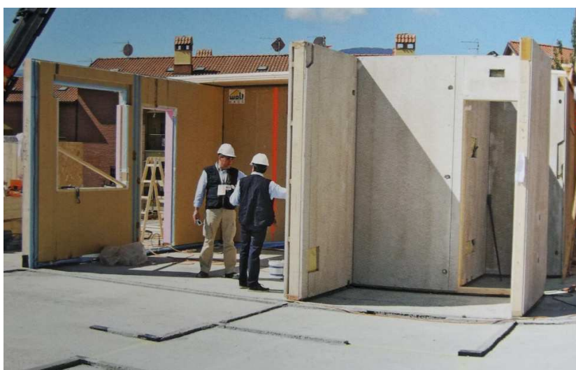
Assemblaggio di pannelli platform frame con predisposizioni impiantistiche.
