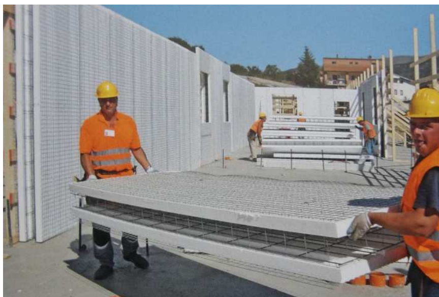
Pareti portanti realizzate con pannelli modulari in polistirene e rete elettrosaldata con getto di completamento in opera.
