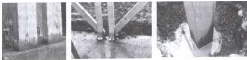
Assorbimento di acqua causato dal contatto con un altro materiale contenente acqua; contatto con il terreno causato da distanza insufficiente o da fondazione diretta.
