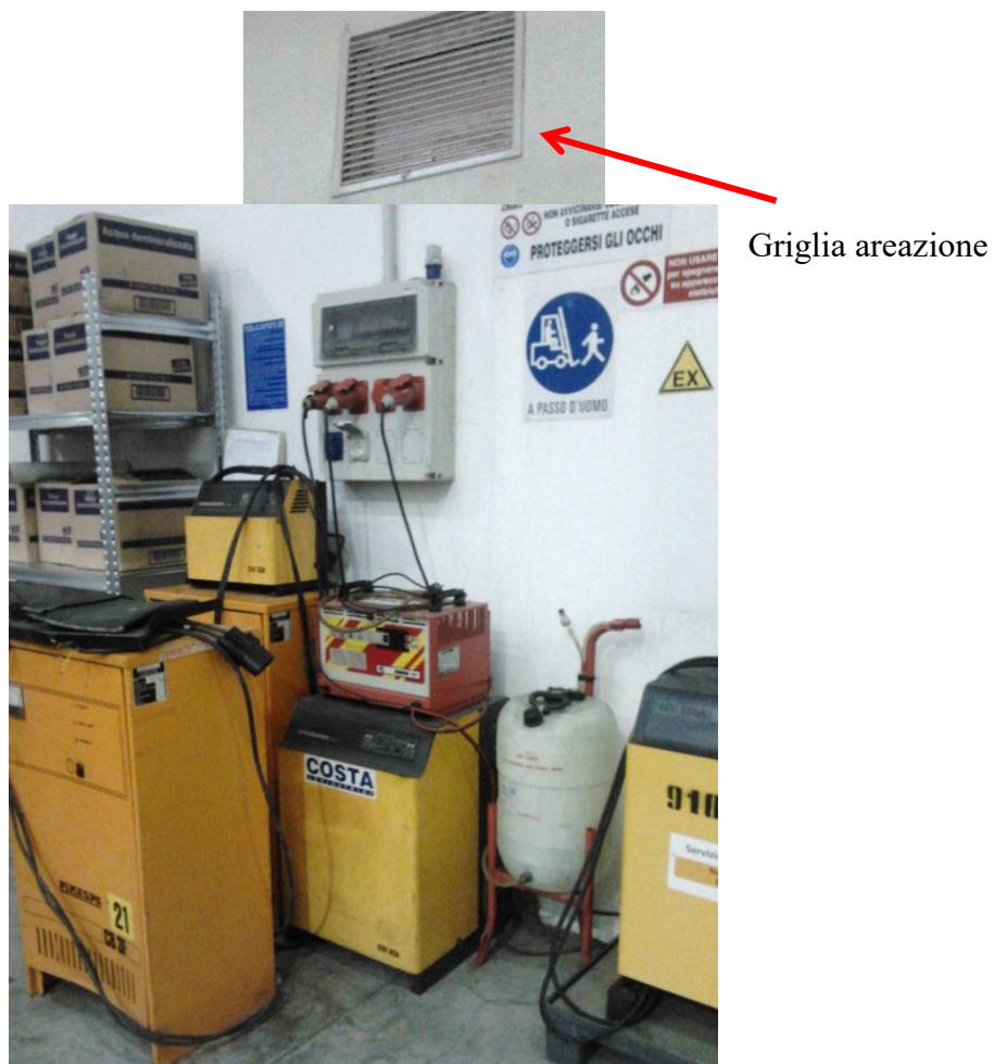
Figura 9.2.2 : Zona ricarica S3, interna, provvista di areazione
