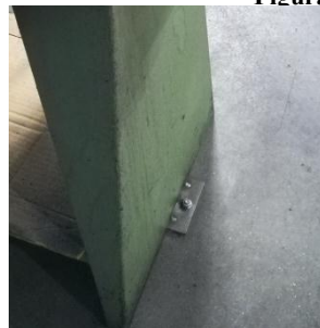
Figura 7.4.3 : ancoraggio a terra
