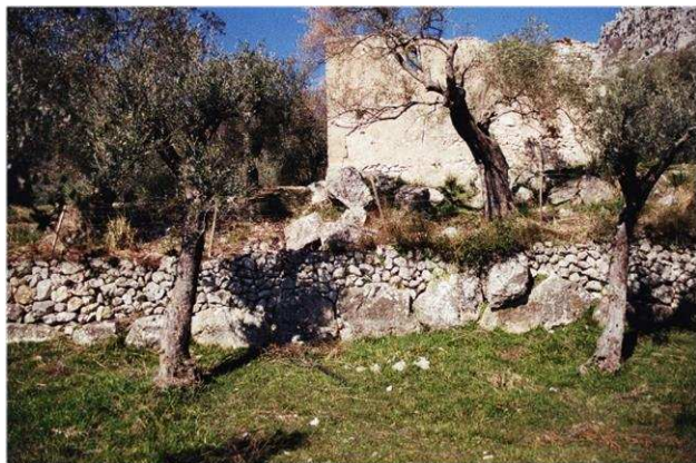
12. Fronte maggiore avanzato, rinzeppature con piccoli conci. Fotografia G. Parisi, 2019.
