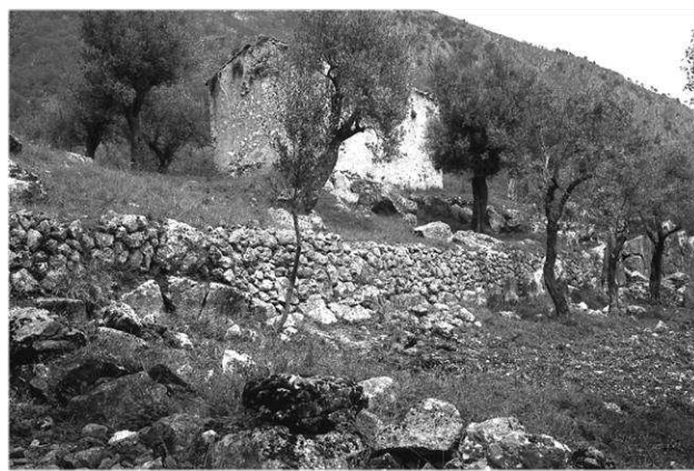
13. Rinzeppature. Archivi Soprintendenza Arch. B.A.P. Molise. In estratto foto 1980, cod. LX - Madonna della Libera 3-29852
