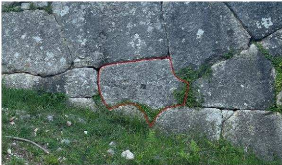
51-52. Venafro, terrazzamento della Libera. Blocchi esagonali con vertice inferiore caratterizzato da due segmenti curvilinei concavi
