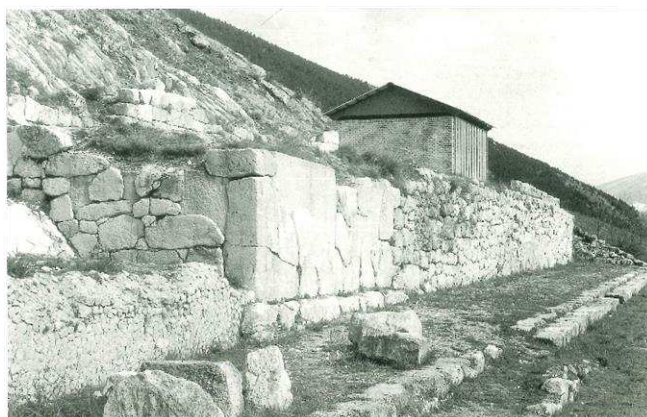
66-67. Sulmona, a sx tratto del podio in poligonale "rifinito", a dx tratto in opera poligonale più "rozza". *
