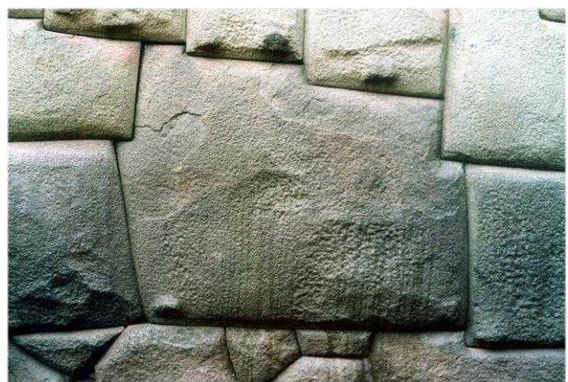
62. Cuzco, Perù. Opera poligonale megalitica, blocchi con faccia superiore d'appoggio a piano sbalzato.
