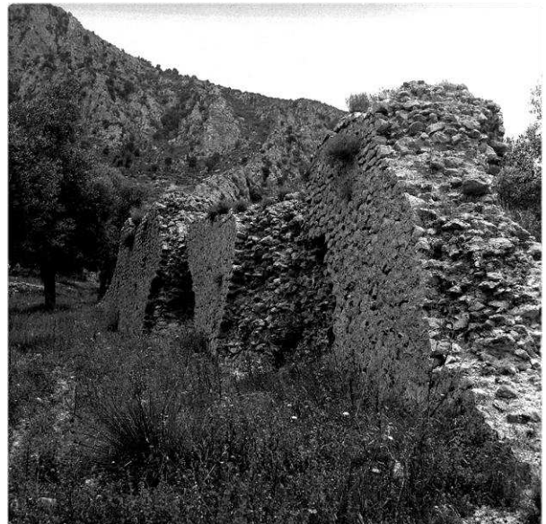
32-33. Le due cisterne presenti a monte del pianoro della chiesetta della libera, di cui una riconvertita in struttura per il ricovero di bestiame. 34. Sulla destra resti in opus caementicium di un probabile acquedotto in collegamento alle cisterne.
