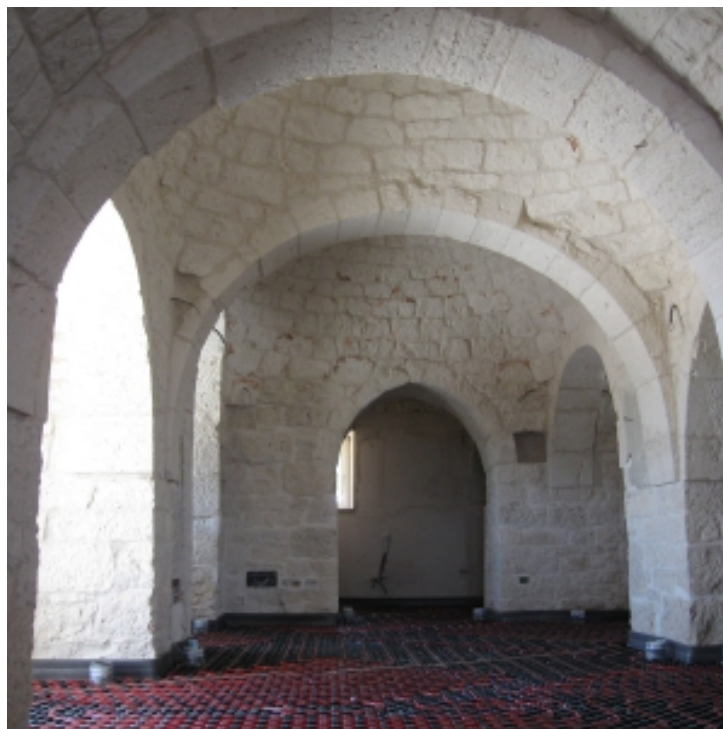
Figura 37 posa impianto a pannelli radianti
