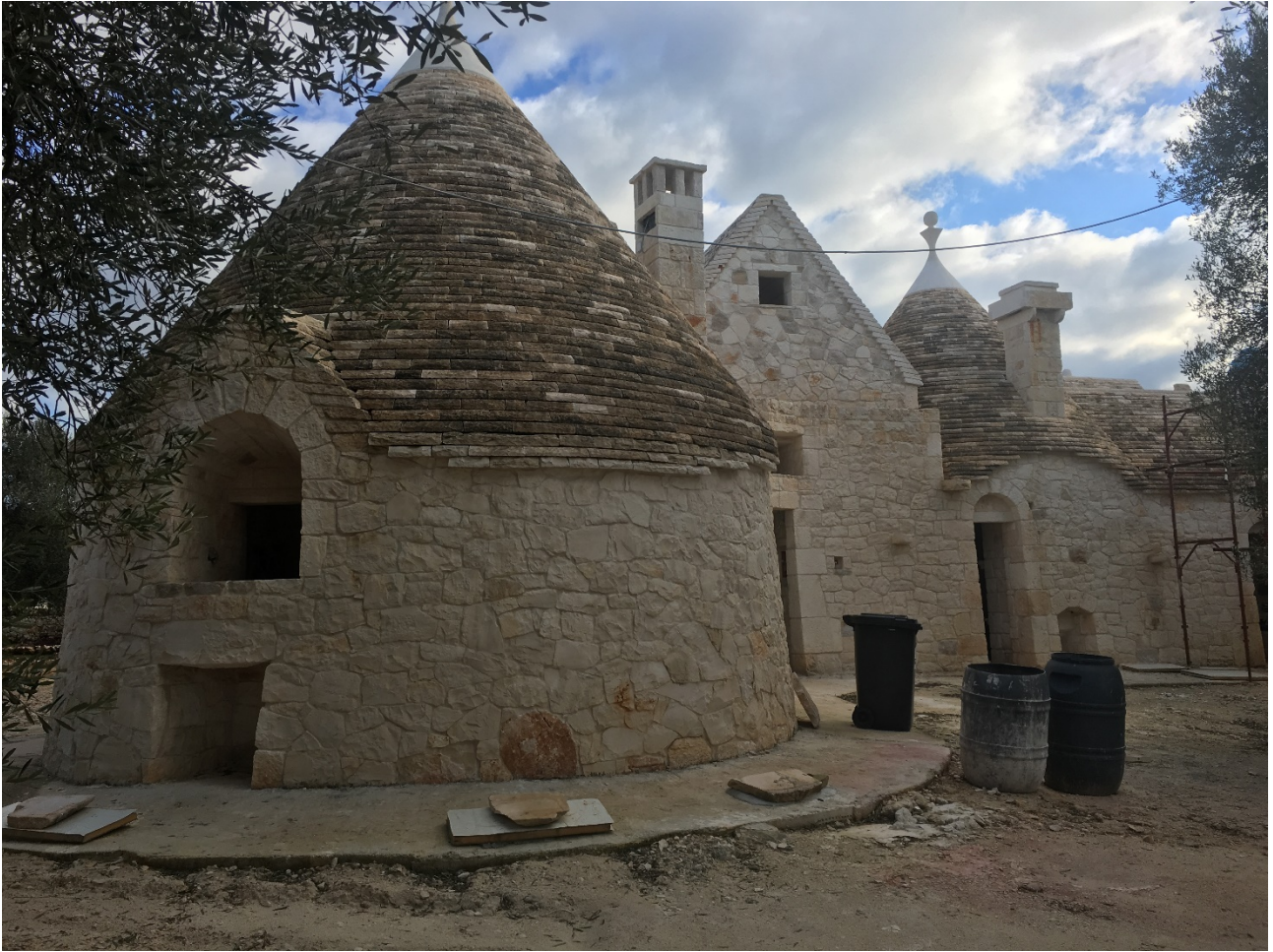
Figura 3 Foto del complesso di trulli a lavori di costruzione quasi ultimati
