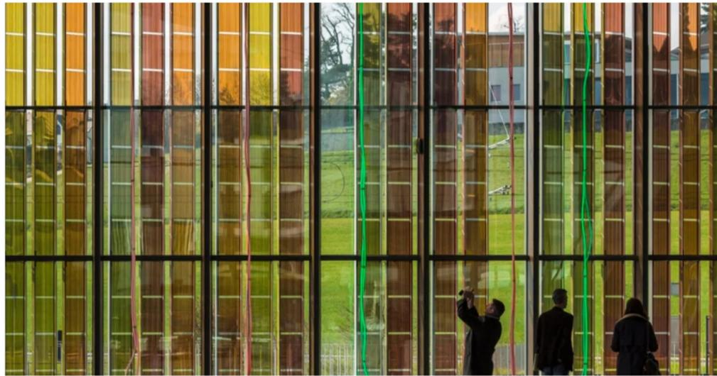
**DSSC (dye sensitized solar cells):** fotovoltaico organico-inorganico, utilizza un elettrolita (titanio) e colorante (rutenio). Definita 'fotosintesi artificiale', con  $\text{CO}_2$ =titanio, clorofilla = colorante. Raggiungono un'efficienza del 12% e hanno durata di vita molto superiore a quelle completamente organiche. Hanno un alto coefficiente di assorbimento.
