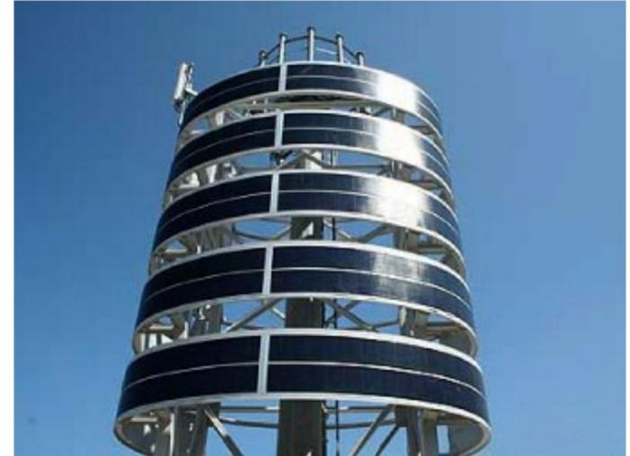
**Tellururo di Cadmio (CdTe)**: materiale che presenta un ottimo coefficiente di assorbimento della luce e un'ottima efficienza di conversione (fino al 22%). Richiede meno acqua per la produzione e ha un tempo di recupero dell'energia minore rispetto alle alte tecnologie e costi inferiori rispetto al silicio amorfo. I materiali impiegati sono però tossici, il processo di fabbricazione è quindi lento e poco flessibile.
