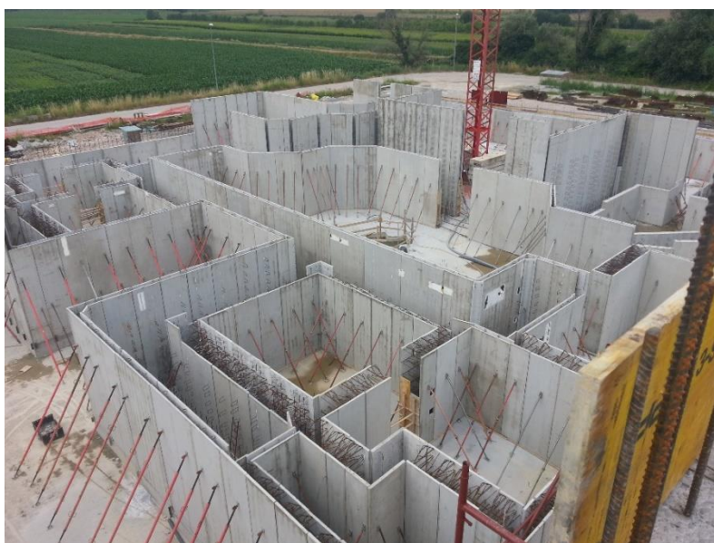
Fig. 3.2 Posizionamento dei pannelli prefabbricati per il getto dei muri di grosso spessore
