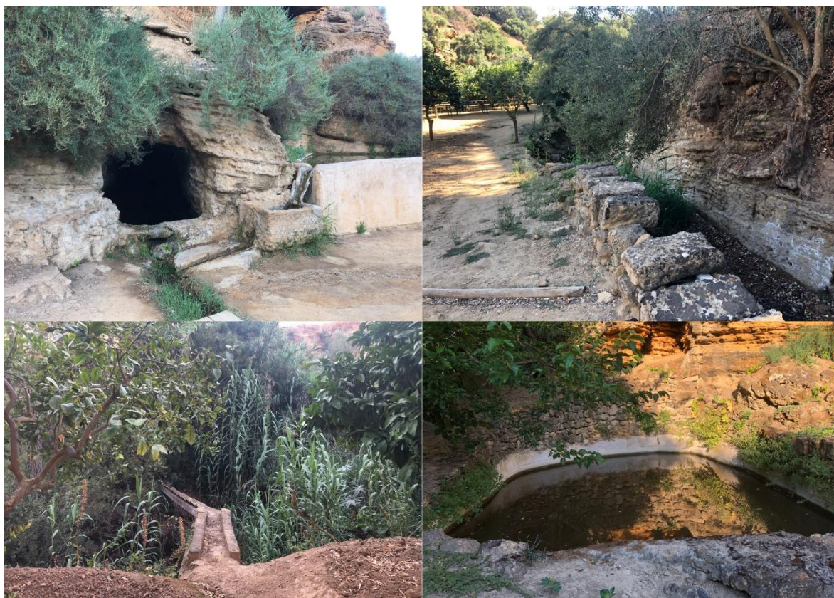
Figura 24. Elementi del sistema idrico della Kolymbethra: accessi ai condotti, strutture di canalizzazione, dispositivi di distribuzione e vasca di accumulo. La compresenza di componenti storiche e interventi
