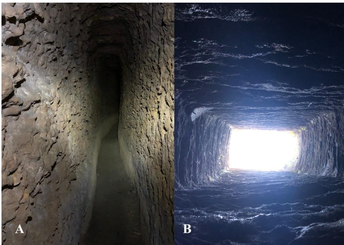
Figura 16. Esempi di strutture idrauliche scavate nella roccia nell'area della Valle dei Templi: a) tratto interno della galleria del sistema ipogeo della Kolymbethra; b) canale scavato nella roccia in corrispondenza del Tempio dei Dioscuri. Fotografie dell'autore.
