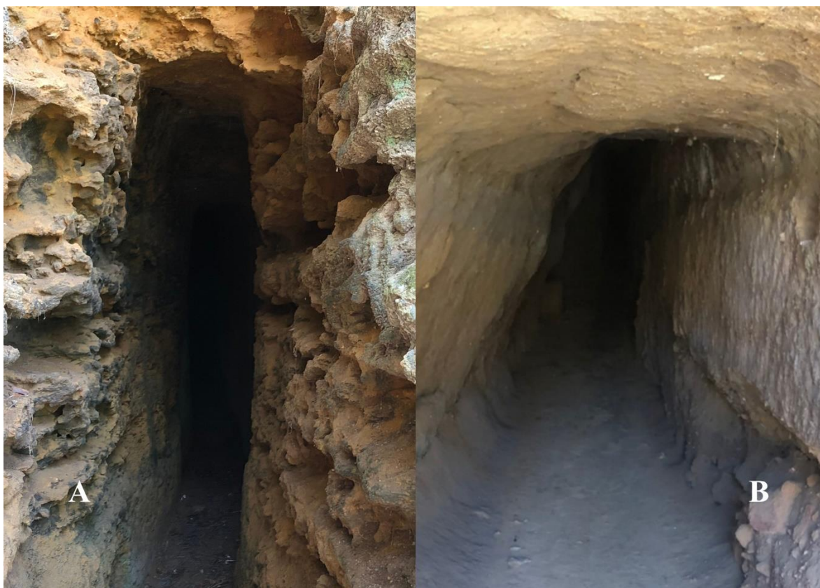
Figura 9. Ingresso al sistema ipogeo della Kolymbethra: a) ingresso dal vallone; b) uscita da Porta V. Fotografia dell'autore.
