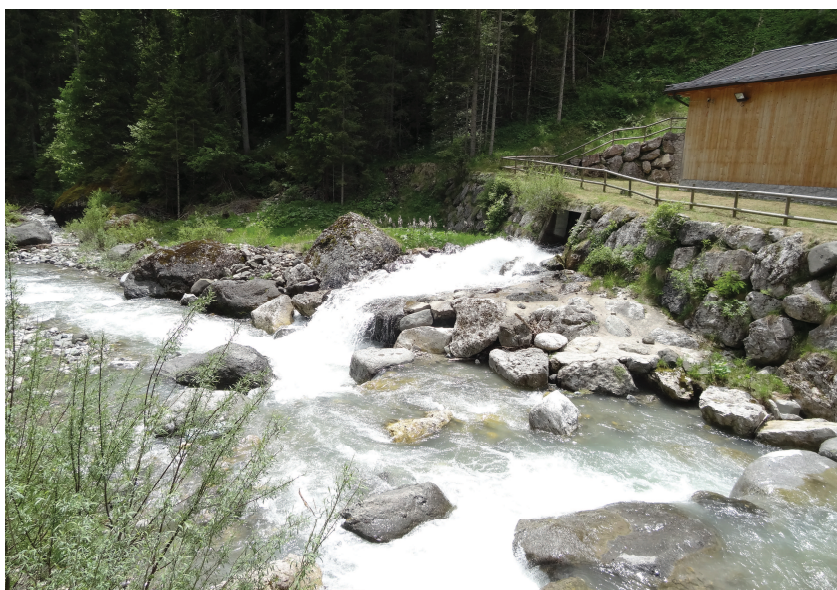
Figura 6.3 – Immissione dell'acqua utilizzata dalla centralina di Davedino
