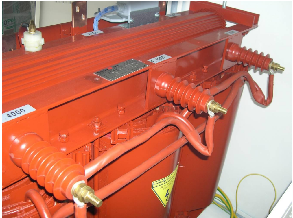
Il trasformatore visto lato media tensione con gli isolatori e i morsetti delle tre fasi.
