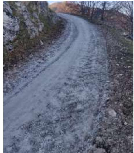
*Figura 20 miscela di calce-cemento sparsa sulla carreggiata prima di essere inglobata nella massicciata in fondo naturale.*
