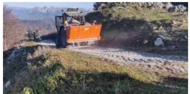
*Figura 21 tramoggia tarata per spargere l'esatta quantità di calce-cemento mentre rilascia la miscela lungo la carreggiata.*
