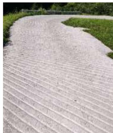
*Figura 29 tratto pavimentato in calcestruzzo con finitura liscia e rigature trasversali oblique.*
