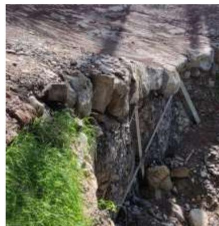
*Figura 23 particolare di un ancoraggio monoblocco posizionato sotto un guado per garantire la tenuta dell'opera in seguito a precipitazioni intense.*
