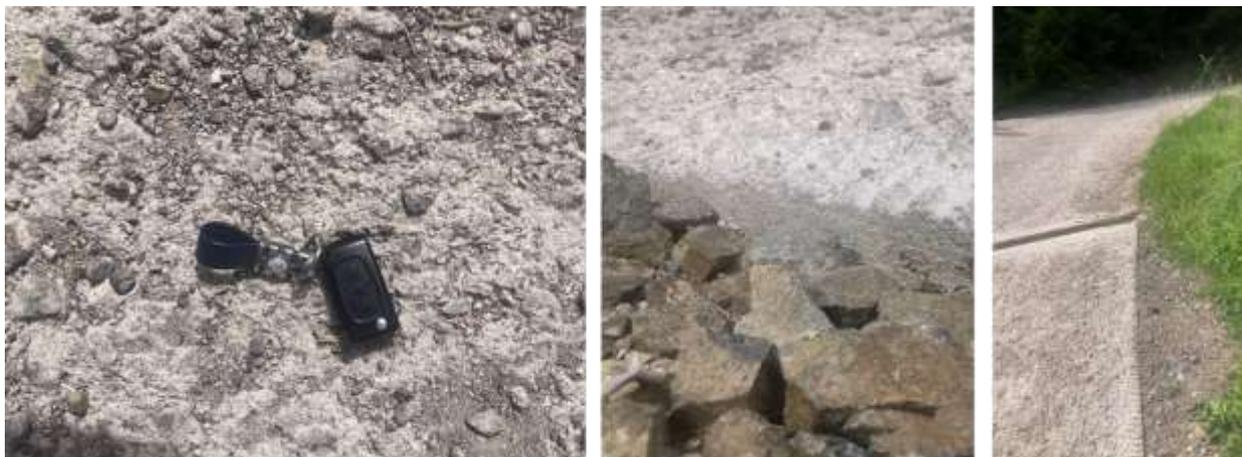
*Figura 31 particolari di una pavimentazione realizzata con calcestruzzo rinforzato da fibre polimeriche in una via di accesso alle aree forestali camionabile nel comune di Predazzo (TN).*
