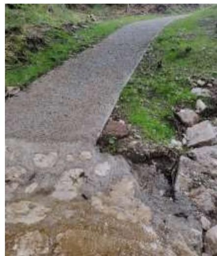
*Figura 10 particolare di un tratto pavimentato con pendenza > 20% in prossimità di un guado realizzato con massi affogati in gettata di calcestruzzo.*
