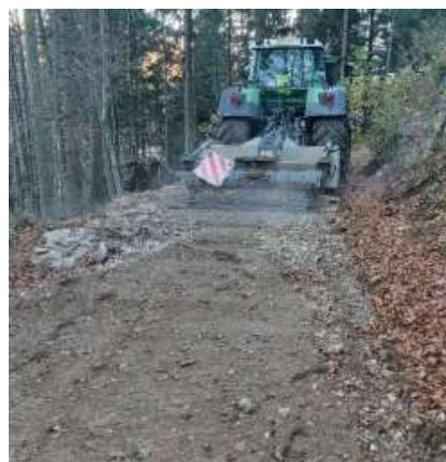
*Figura 19 seconda passata della fresa martellante trainata da un trattore di idonea potenza.*
