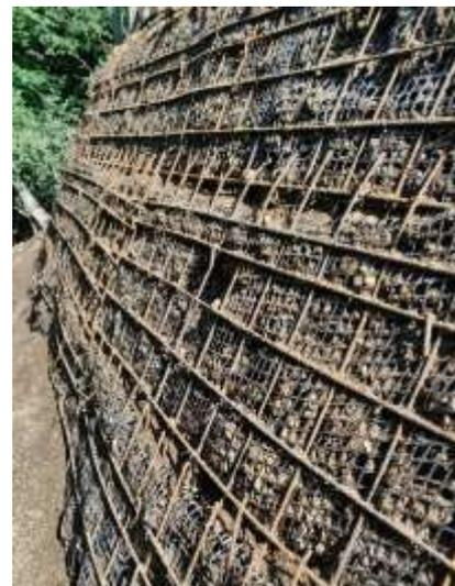
*Figura 27 particolare di una terra armata appena realizzata. Per completare la lavorazione sarà necessario idroseminare al termine dei lavori.*
