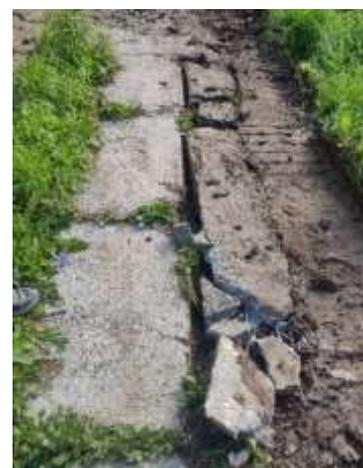
*Figura 9 particolare della pavimentazione degradata da sostituire.*
