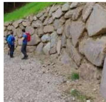
*Figura 28 scogliera realizzata al piede di una frana, per bloccarne l'avanzamento. L'opera è stata realizzata sulla catena del Lagorai, quindi è stato utilizzato del materiale porfirico, tipico della zona.*
