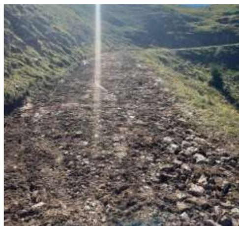
*Figura 26 carreggiata appena dopo essere stata scarificata, dove si nota la matrice drenante del suolo e l'assenza di materiale di grosse dimensioni.*
