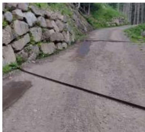
*Figura 25 tre canalette trasversali realizzate a circa 20m l'una dall'altra in un tratto con pendenza circa del 13% in area boscata, ma senza copertura arborea a causa delle conseguenze della tempesta Vaia.*
