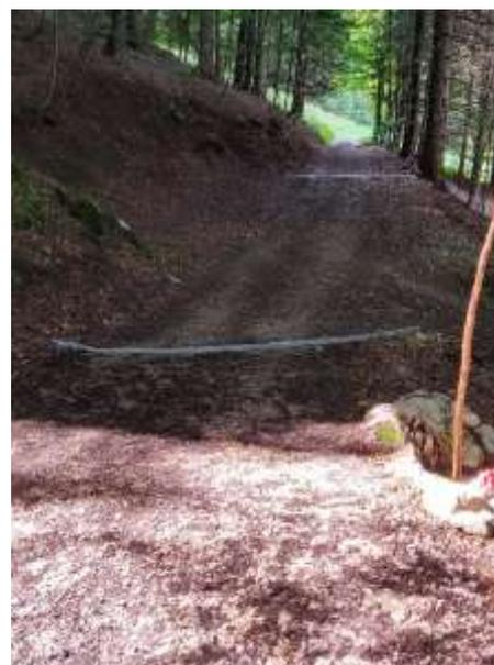
*Figura 14 particolare di congiunzione tra un tratto pavimentato e un tratto in fondo naturale stabilizzato.*
