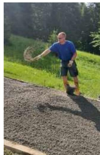
*Figura 12 operaio getta manualmente del pietrisco sulla gettata fresca per migliorare l'inserimento visivo dell'opera nell'ambiente circostante.*
