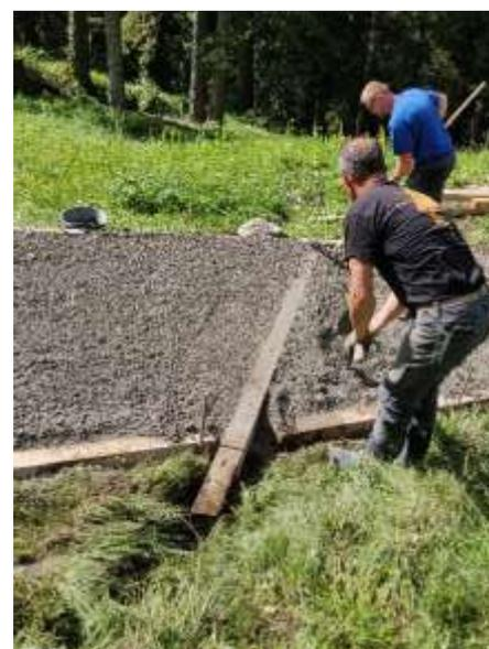
*Figura 11 realizzazione di una canaletta trasversale tramite inserimento di un travetto nella gettata.*
