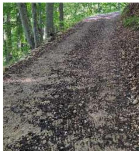
*Figura 13 particolare di una pavimentazione realizzata un anno prima del sopraluogo, con particolare sulla colorazione brunastra dopo la caduta del fogliame.*
