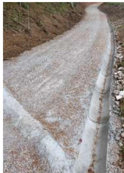
*Figura 17 tratto pavimentato con sezione in trincea, si nota una canaletta trasversale e la canala longitudinale per difendere la sponda dall'erosione. Si può notare come la quantità di ghiaino sparso in questo tratto sia inutilmente abbondante.*
