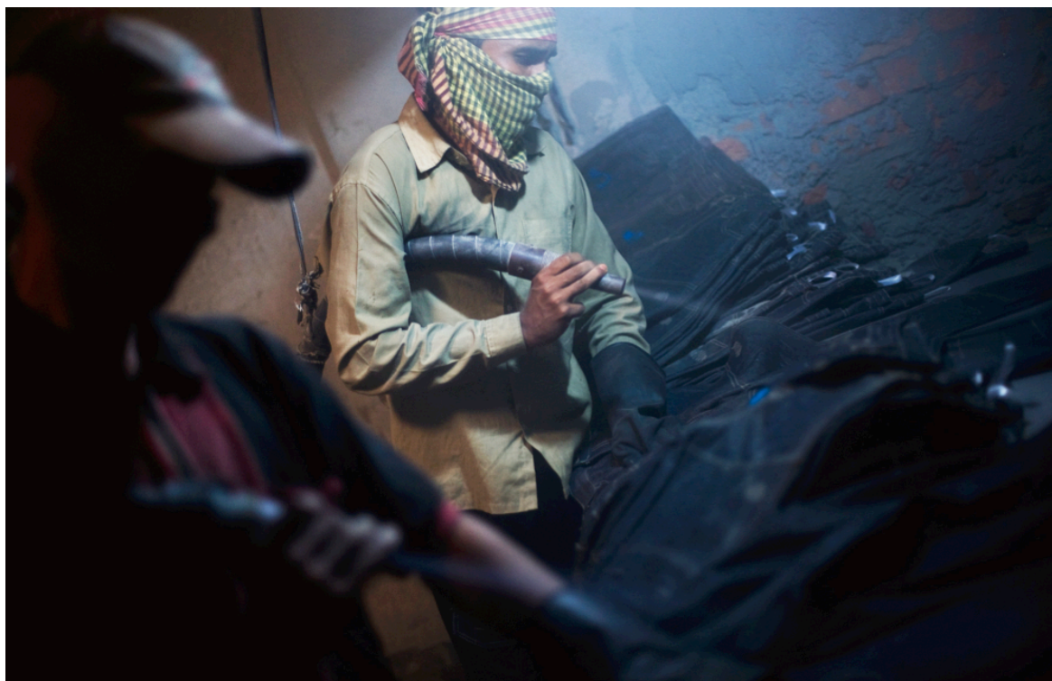
Figura 10 - Operai con dubbie protezioni mentre praticano la tecnica del "sandblasting"
