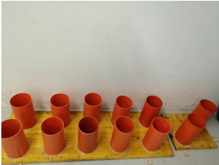
Figura 4 _ Preparazione dei casseri
