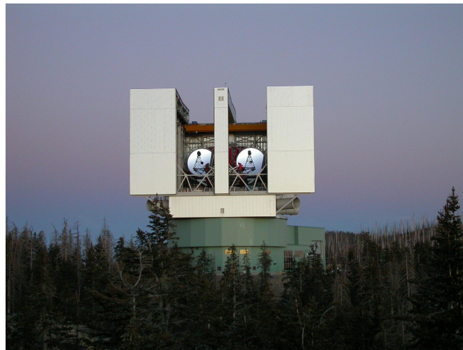
Figura 1.4: Il Large Binocular Telescope è costituito da due specchi di diametro di circa 8.5 m ognuno. Grazie all'interferometria, la risoluzione dello strumento è pari a quella di un unico telescopio avente diametro di 22.7 m. In questo modo si evitano le problematiche tecniche legate alla costruzione di uno specchio di tali dimensioni. Immagine: Wikimedia Commons.
