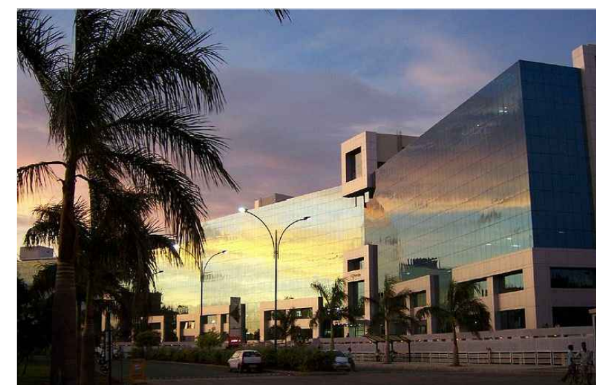
Foto di uno degli edifici che costituisce la cosiddetta cyber-city
