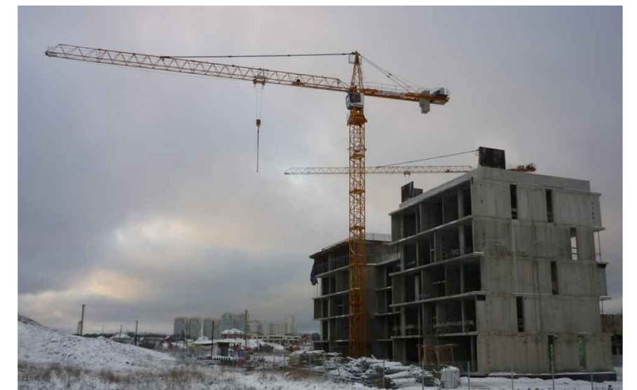
Foto del cantiere datata Novembre 2013
