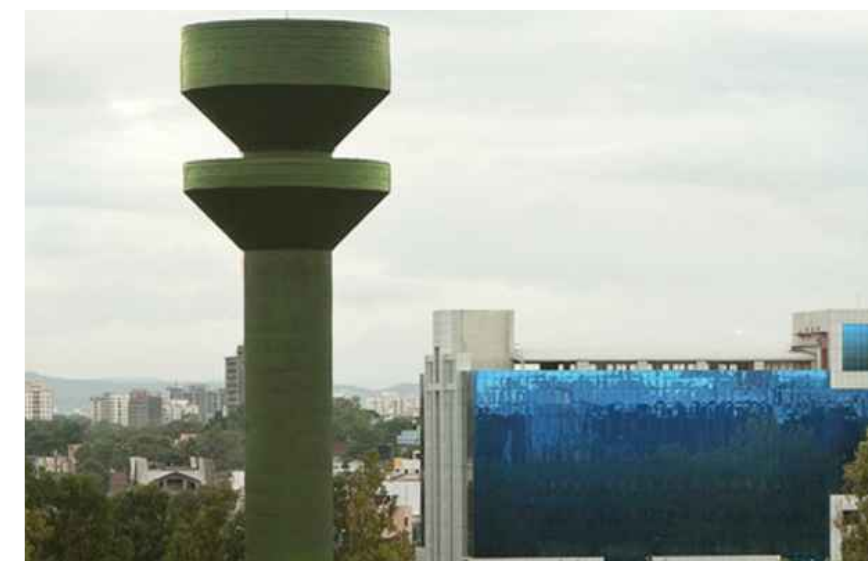
Particolare della torre piezometrica dell'acquedotto di Magarpatta
