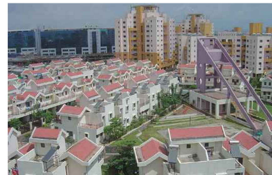
Edifici residenziale sulle cui coperture sono installati pannelli fotovoltaici
