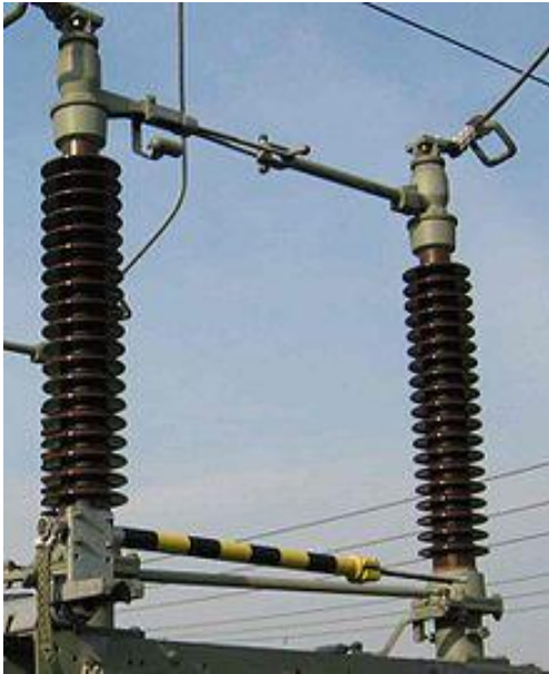
Figura 19. Sezionatore chiuso.
