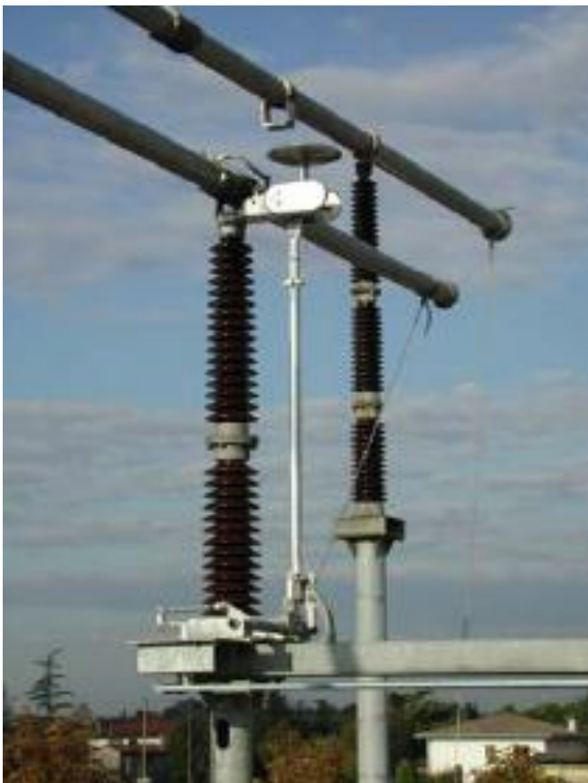
Figura 10. Esempio di sezionatore di comprensivo di lame di terra.
