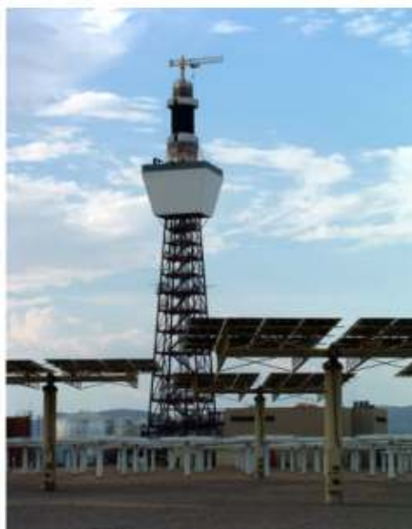
Figura 2.5.1.6 - Impianto a torre solare (centrale solare a Daggett in California) (Giovannelli, 2009)
