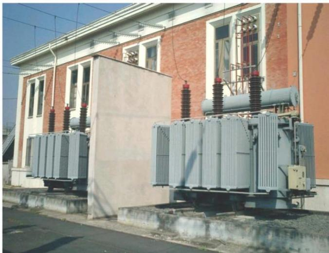
Figura 3.2.7: Trasformatore di potenza AT/MT da 132 kV.
