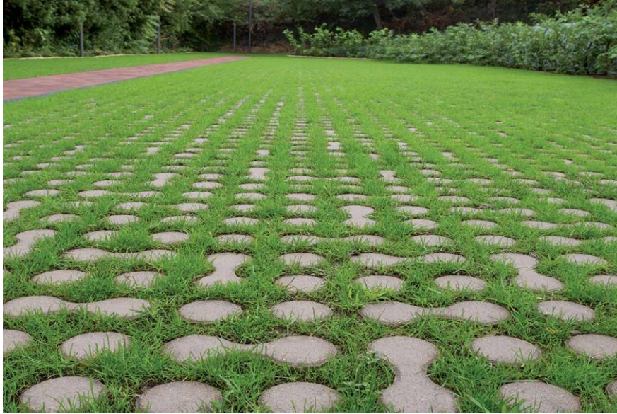
Figura 3 – Una tipologia di Pavimentazione Permeabile collocata all'interno di un giardino pubblico (Credit Ferrari BK)
