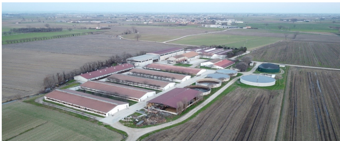
Fig. 22 – vista dall’alto sito 1, foto scattata con drone
