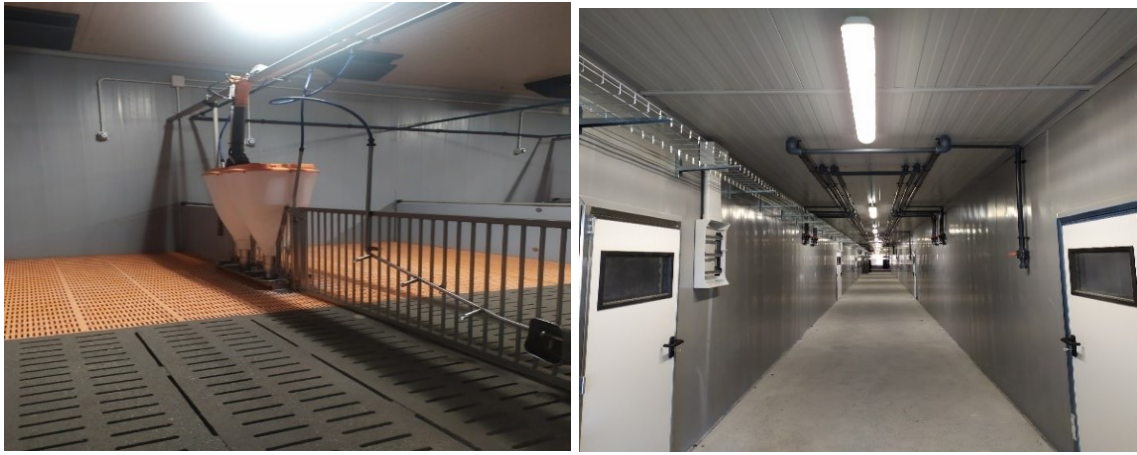
Fig. 25a – particolare della stanza, 25b – corridoio interno alla stalla
