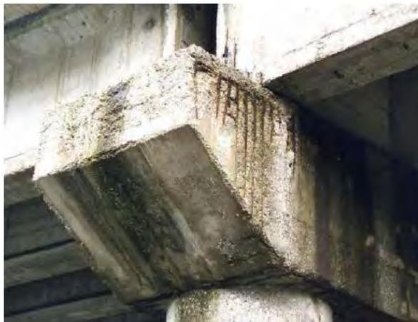
Espulsione del copri ferro a causa dell'ossidazione delle armature provocata dalla percolazione delle acque meteoriche.
