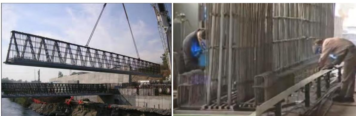
Travi NPS® lunghe 24m (con basamento in cls) realizzate da Tecnostрукture® per il ponte ferroviario della Muzza (BG).
