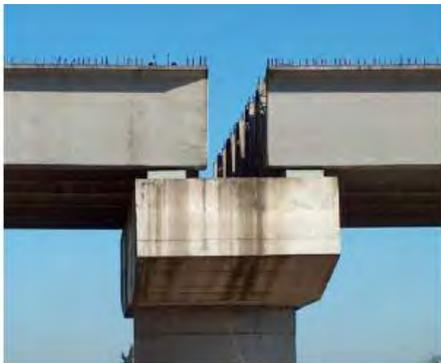
Fase 1: Preparazione inghisaggi traverso all'estradosso pulvino e infissione connettori all'interno delle travi
