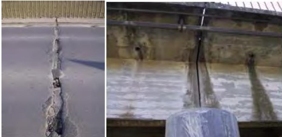
Giunto coperto dalla pavimentazione e poi fessurato dalla dilatazione termica. Di seguito la percolazione delle acque meteoriche attraverso il giunto e poi sulle strutture portanti. Ponte sull'Adige ad Albaredo (VR). (Corso di progettazione di Ponti, UNIPD, 2011-2012)
