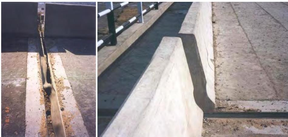
Danneggiamento del giunto d'espansione a causa dell'eccessivo movimento dello stesso in seguito ad azione sismica. Nuovo ponte Surajbari, India. (Tandon M., 2005)
