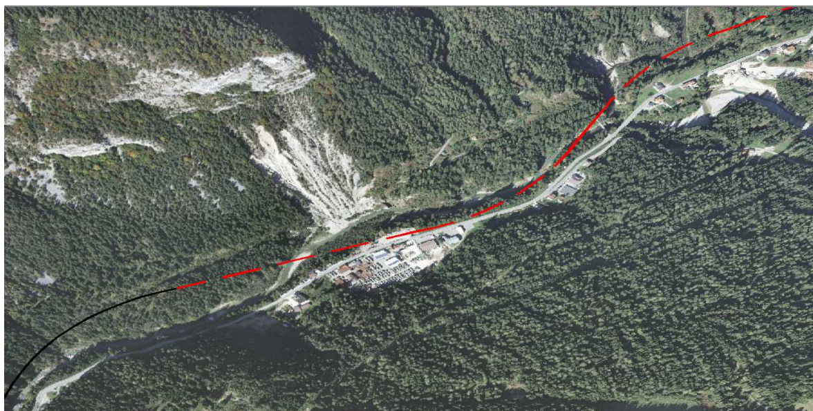
Figura 64: Frana del Ruoiba
