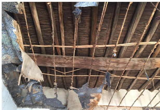
Figura 5.8. Soffitto tradizionale con la stratigrafia illustrata in Figura 5.4
