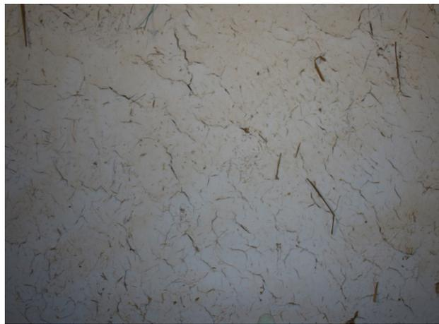
**Figura 5.14.** Intonacatura interna in terra deteriorata, traspare la paglia dell'intonaco
