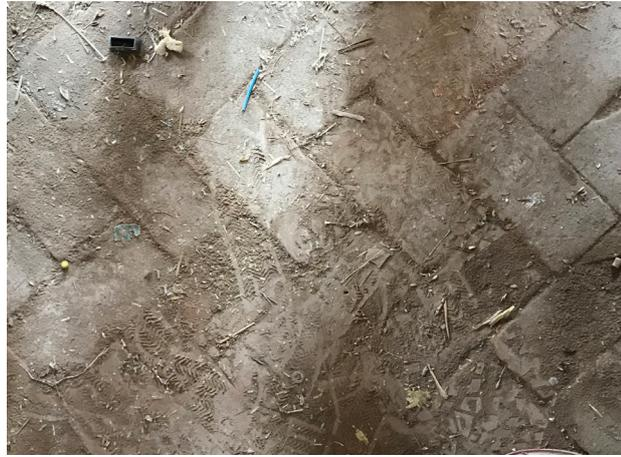
**Figura 5.13.** Pavimento tradizionale con mattoni disposti a spina di pesce
