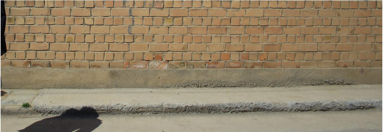
**Figura 5.16.** Cordolo fondazionale in cemento presente nelle case in laterizio, In facciata viene spesso coperto con le piastrelle
