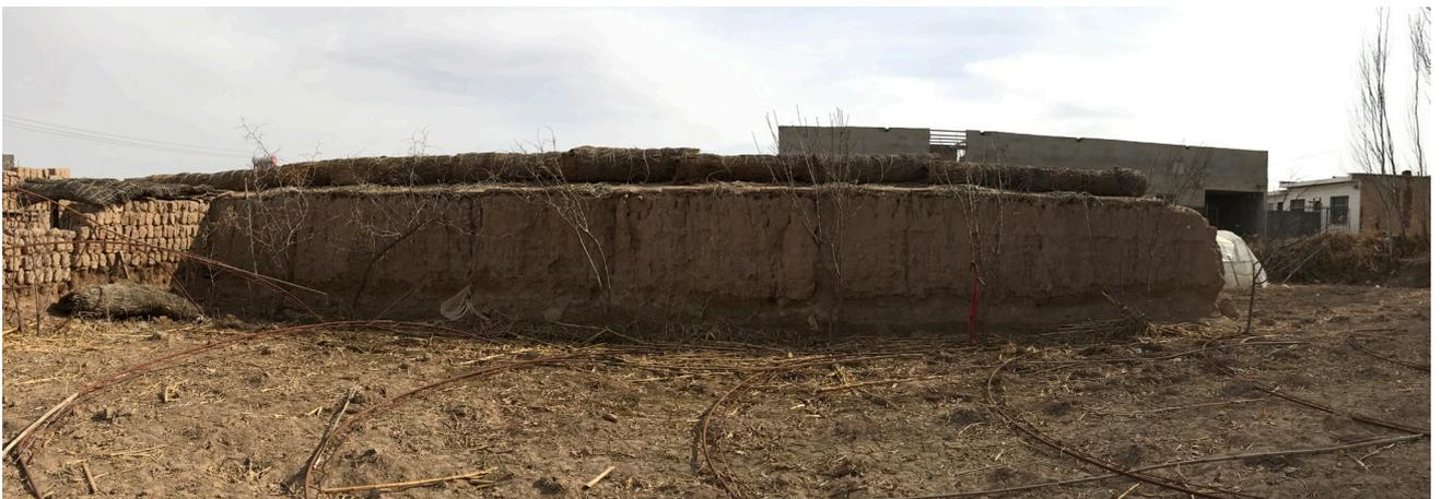
**Figura 5.18.** Retro di una serra realizzata in terra.
