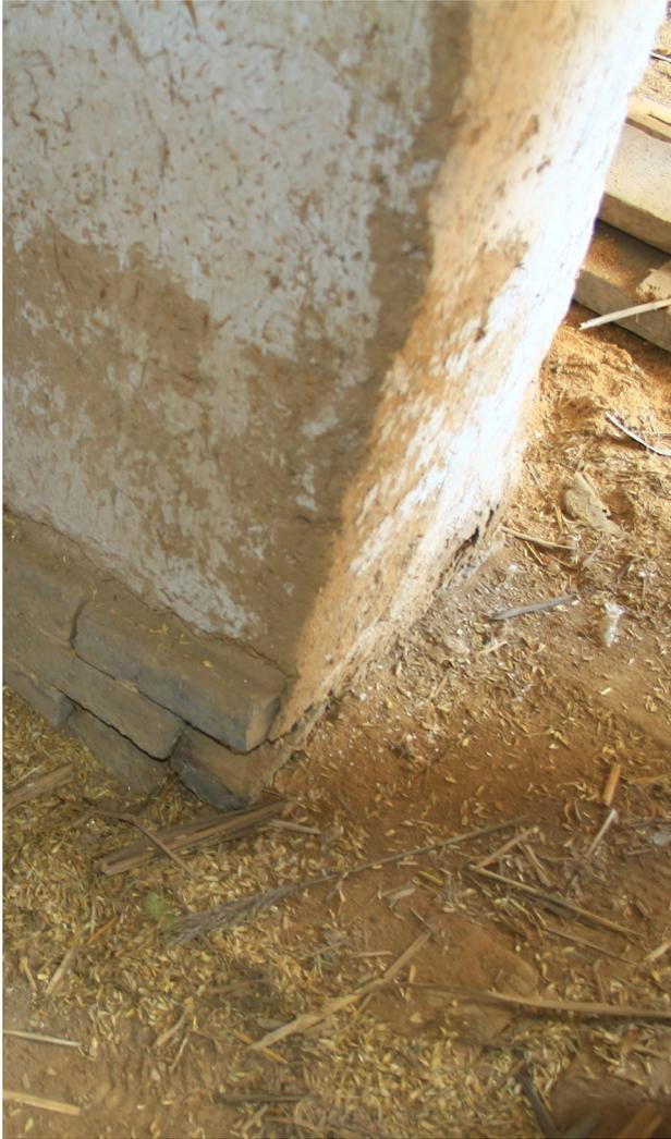
**Figura 5.12.** Fondazione interna di una casa in adobe realizzata con mattoni in laterizio
