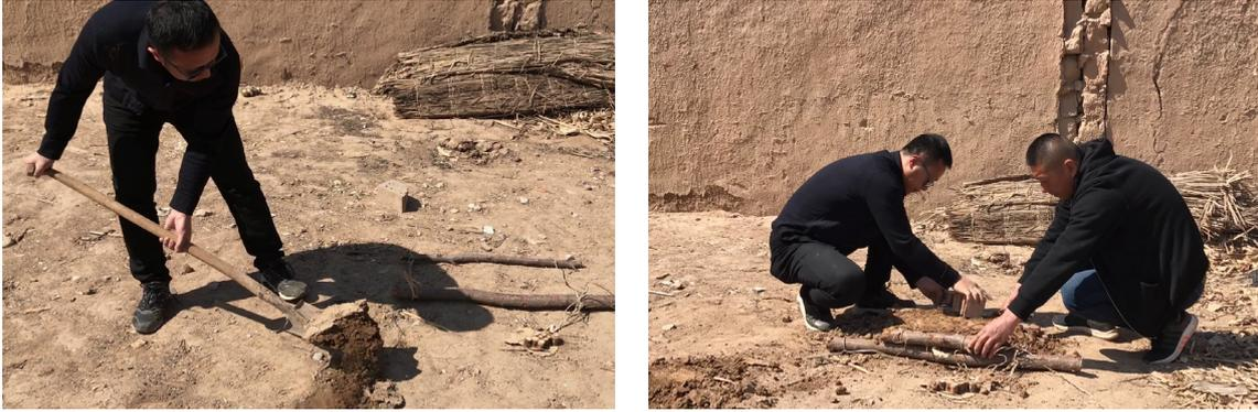
**Figura 7.1** Queste due foto ritraggono i passaggi per realizzare il muro in terra battuta, partendo dalla creazione del cassero, ponendovi all'interno la terra, compattandola e reiterando il processo
