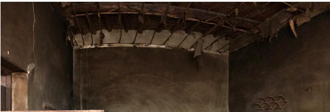
**Figura 5.15.** Annerimento delle pareti dovuto al monossido di carbonio emanato dalla stufa non con sfiato non correttamente realizzato. La fasica bianca nella parte alta del muro è il colore originale dell'intonaco, conservato grazie al controsoffitto in carta
