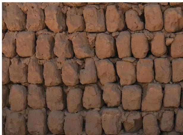
Figura 5.10. Esempio di muro in adobe presente nell' area.
