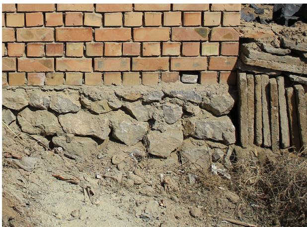
Figura 5.7. La fondazione pietra tipica delle case nell' area di progetto
