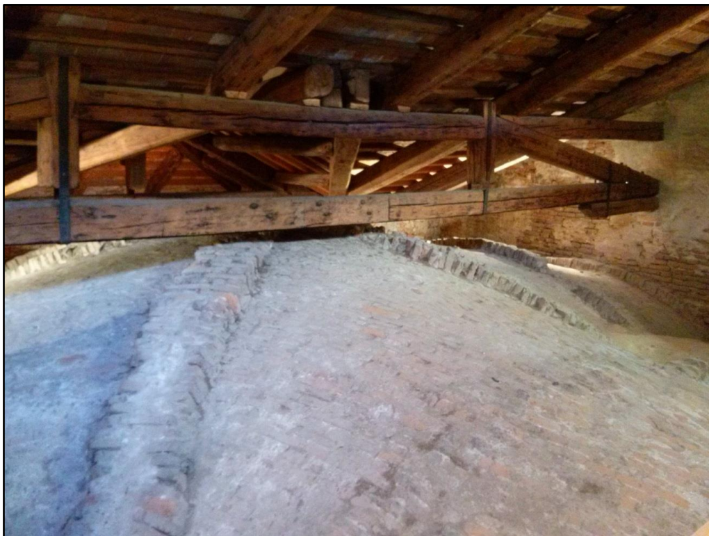
Foto 21: volta della sala crociata centrale (fonte dell'autore)
