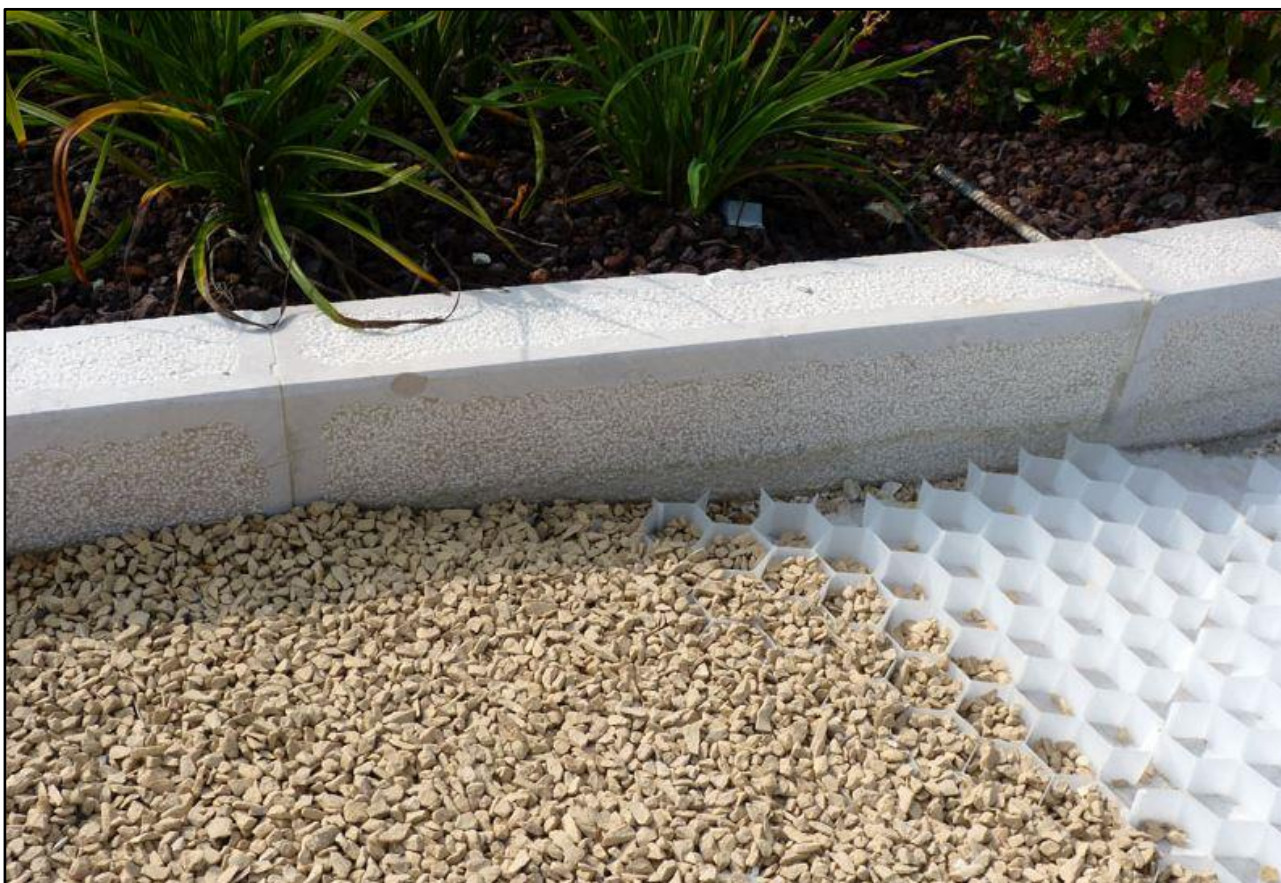
Foto 31: esempio della struttura esagonale a nido d'ape (fonte: www.block-rock.it )
