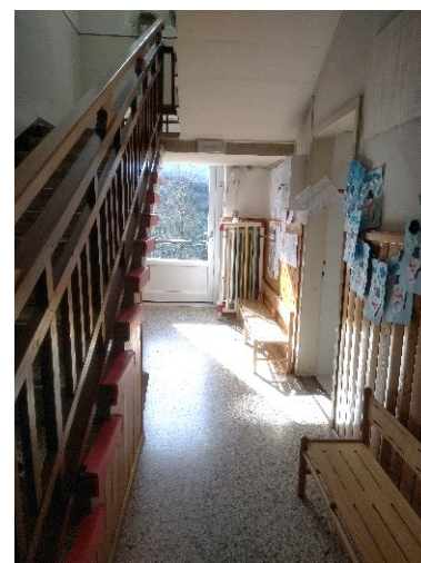
Figura 15 Scale interne di collegamento viste dalla Scuola dell'infanzia e uscita per il giardino
