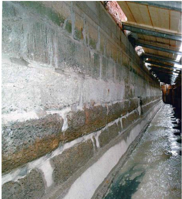
Fig. Documentazione fotografica dell'intervento; infissione delle palancole, iniezione di miscele leganti, ricostruzione del muro di sponda
