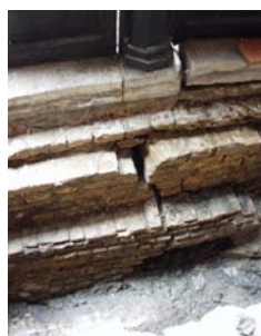
Immagini relative allo stato di conservazione dei muri di sponda raccolte dopo lo scavo interno
