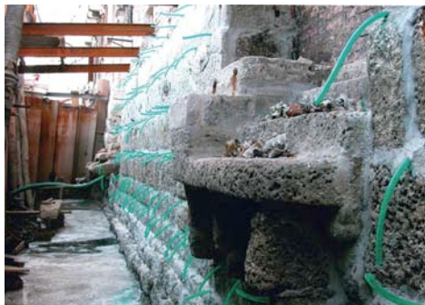
Fig. Documentazione fotografica dell'intervento; infissione delle palancole, iniezione di miscele leganti, ricostruzione del muro di sponda
