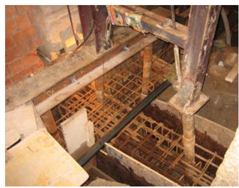
Immagini relative allo stato dell'edificio pre-intervento e delle fasi esecutive della sottofondazione
