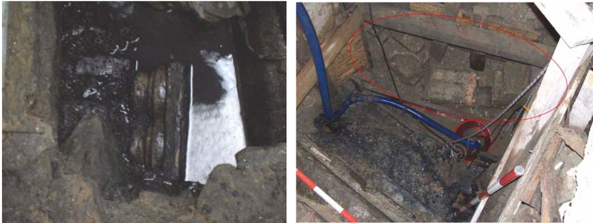
Fig.6.11 Documentazione fotografica dell'Ispezione fondale n°11 con evidenza delle antiche fondazioni; Fig.6.12 Documentazione fotografica dell'Ispezione fondale n°6 con rinvenimento dei resti dell'antica cisterna
