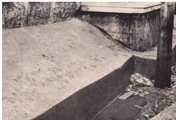
Fig.5.4, 5.5 Intervento di consolidamento con cordolo in c.a. a Palazzo Dario realizzato verso la fine degli anni '70 tratto da Zuccolo G., Il restauro statico nell'architettura di Venezia , Istituto Veneto di Scienze Lettere ed Arti, 1975
