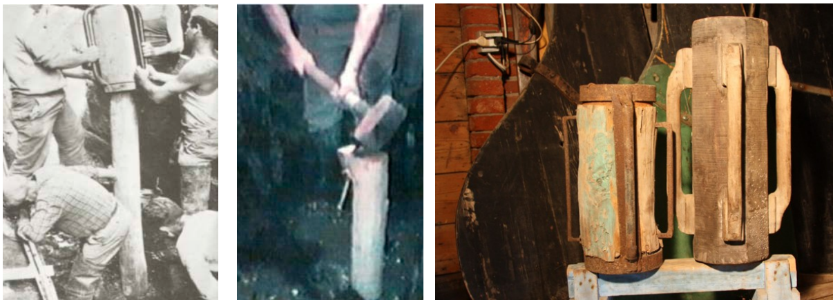
Fig.1.5 Battipalo al lavoro, immagine storica tratta da Zuccolo G., Il restauro statico nell'architettura di Venezia , Istituto Veneto di Scienze Lettere ed Arti, Venezia, 1975; Fig.1.6 Infissione di un palo ligneo, foto storica; Fig. 1.7 Magli utilizzati per l'infissione manuale delle palificate, con manubri per l'impugnatura manuale
