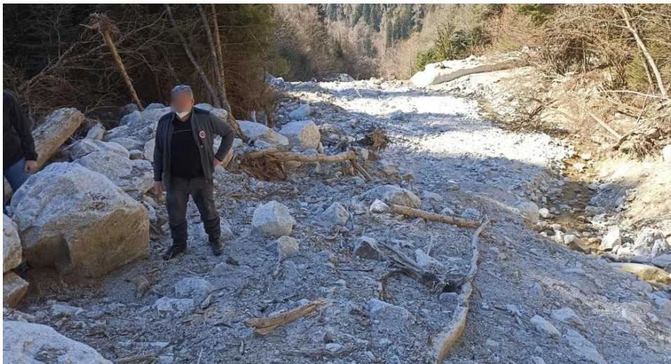
Figura 5.3.2: Canale tra seconda e terza briglia di consolidamento, evidente il cordone laterale sulla sinistra della foto
