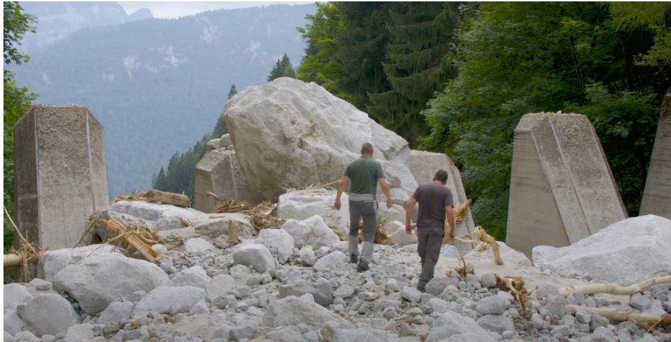
Figura 5.3.1: Accumulo sulla briglia filtrante, particolare su masso (Foto: da montaggio di Fondazione Museo Storico del Trentino)
