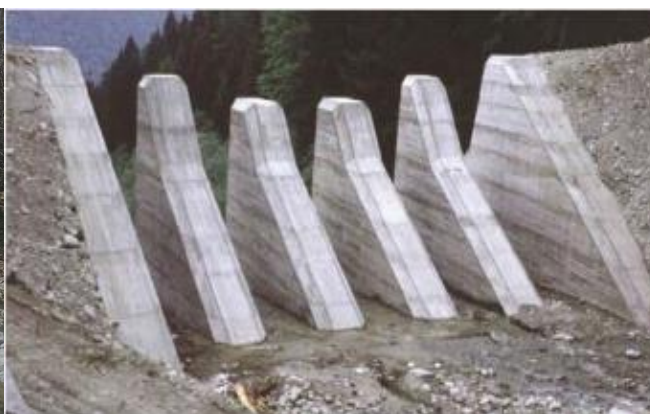
Figura 3.2.3: La briglia filtrante in oggetto, fotografata alla fine dei lavori di costruzione (foto: Servizi Bacini Montani di Trento, 1991)
