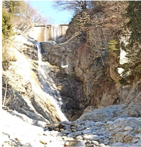
Figura 5.2.1: Tratto in roccia compreso tra la terza e la quarta briglia di consolidamento
