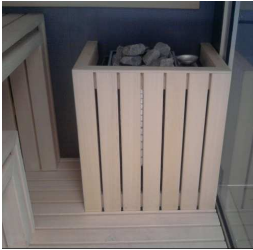
Figura 2.3: Protezione stufa in “AYOUS”
