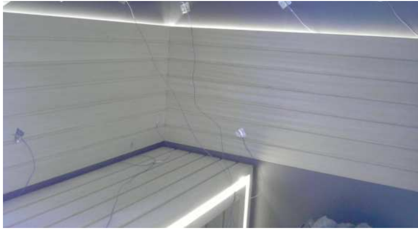
Figura 4.1: Termocoppie tipo J posizionate a pareti per il rilevamento della temperatura dell'ambiente
