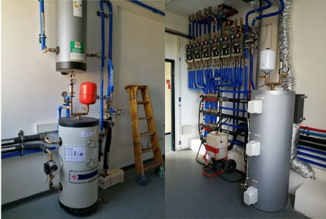
Figura 1.2 - Serbatoio freddo e collegamento con il circuito del chiller (sinistra); serbatoio caldo e circuiti secondari (destra)
