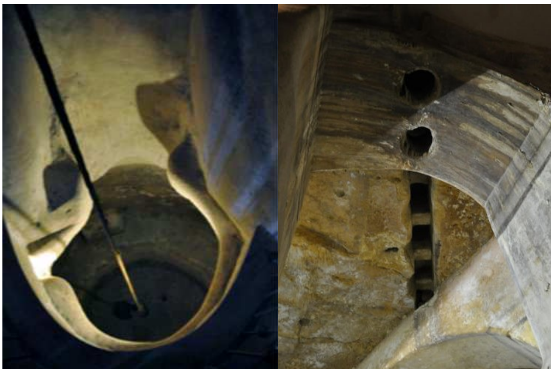
(a) Pozzo cisterna piccola
