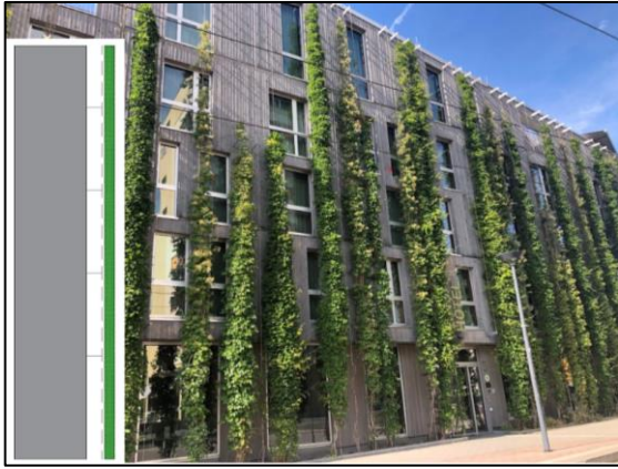
Figura 2.5 - Facciata verde in un albergo a Vauban (Friburgo)
