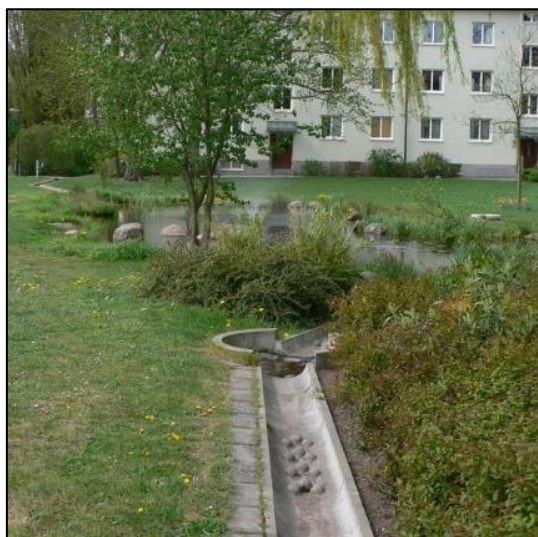
Figura 3.2 - Impianti di stoccaggio per l'acqua piovana (Fonte: © Town and Country Planning Association).
