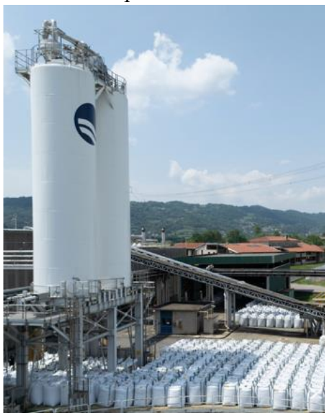
Figura 2.2.1: silos fango essiccato e big-bags (Archivio di Acque del Chiampo S.p.A. Società Benefit, 2026)
