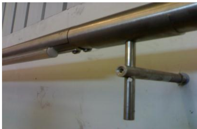
Fig.3.3 - Dettaglio corrimano illuminante: fissaggio a parete
