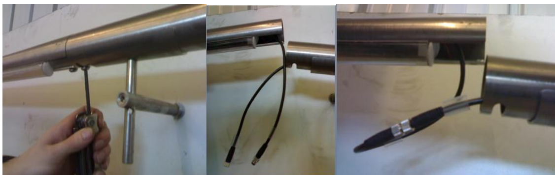
Fig.3.4 - Dettaglio corrimano illuminante: connessione modulo apparecchio illuminante – blocco di fissaggio a parete; collegamento stringhe di moduli attigui attraverso blocco di fissaggio a parete.
