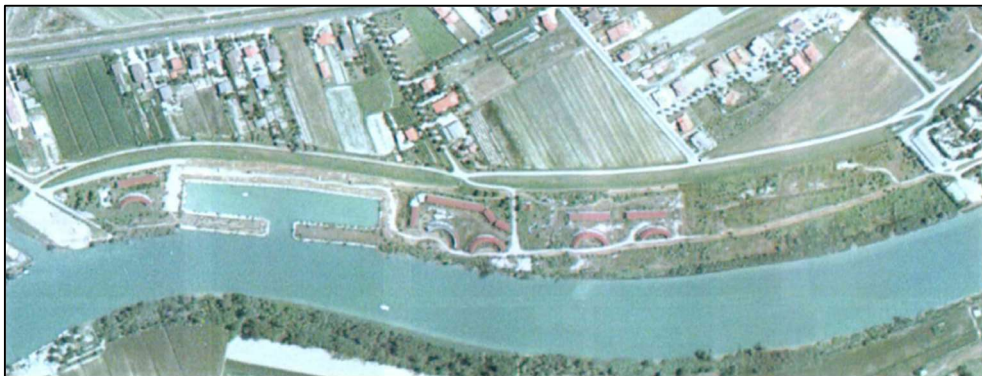
- Figura 12: Foto satellitare delle opere realizzate da demolire (Comune di Lignano Sabbiadoro)
