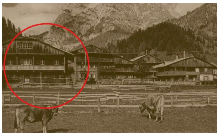
Figura 2.22 Foto d'epoca della borgata Cima Sappada in cui è possibile vedere la casa prima di essere adibita a B&B e quindi ristrutturata.
