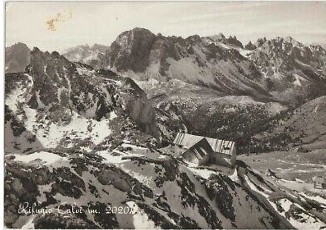
Figura 2.27 Foto del Rifugio Pier Fortunato Calvi 1963.
