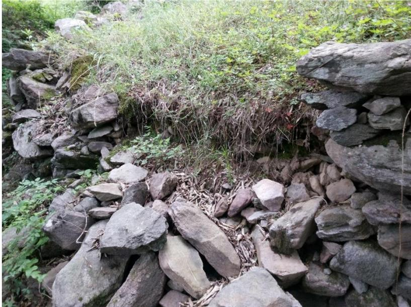
*Figura 8: Porzione di muro a secco crollata in un terrazzamento abbandonato e prossimo al recupero presso l'azienda agricola Scraleca*
