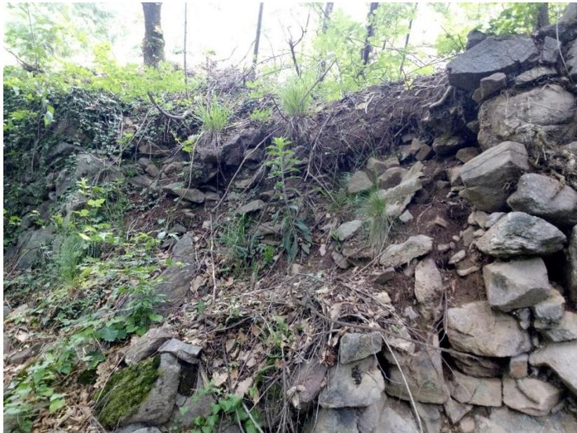
*Figura 9: Porzione di muro a secco crollata in un terrazzamento abbandonato e prossimo al recupero presso l'azienda agricola Scraleca*
