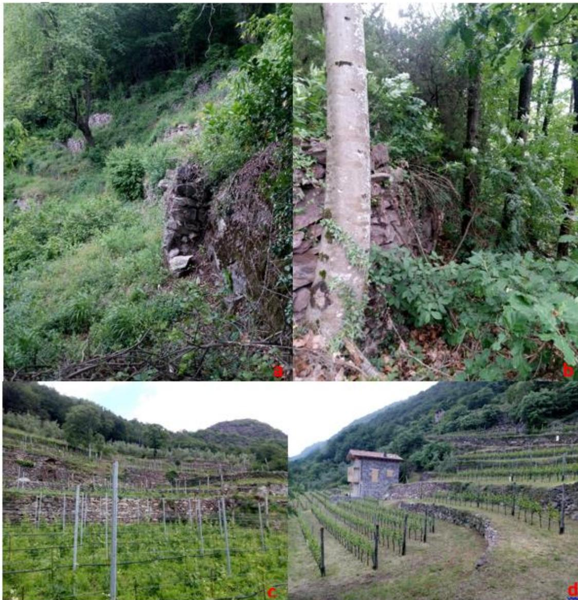
*Figura 16: Esempio di terrazzamenti abbandonati (che presto saranno recuperati) presso l'azienda agricola Scraleca (a, b) ed esempi di recupero dei muri a secco effettuati presso l'azienda (c, d)*
