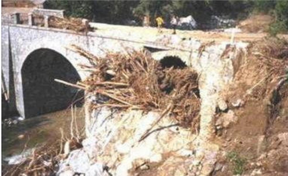
**Figura 2.3 – Soverato (CZ), 10 Settembre 2000: occlusione della luce di un ponte da parte di materiale vegetale trasportato**
