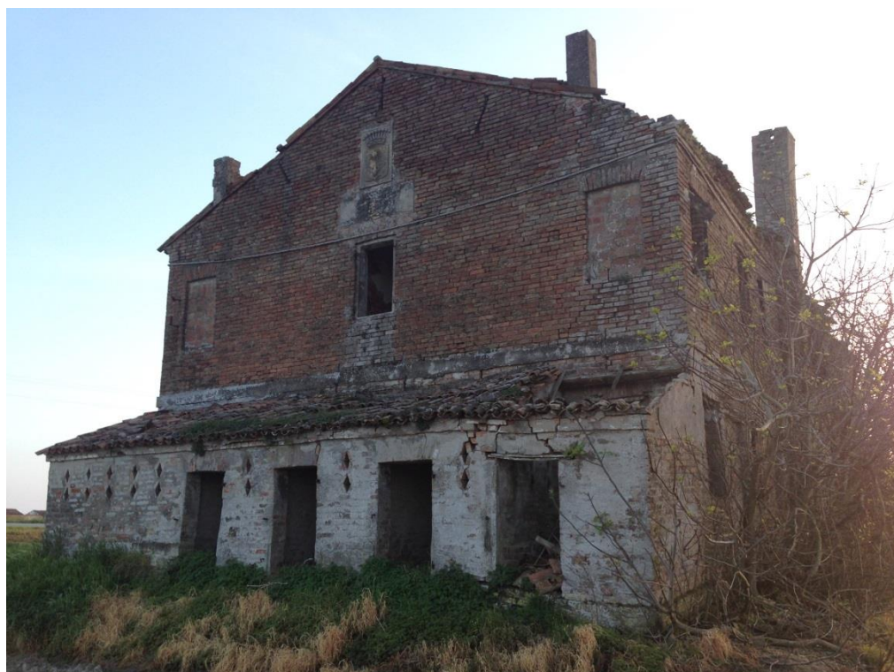
Figura 4.8: Prospetto Nord-Est dell'abitazione.
