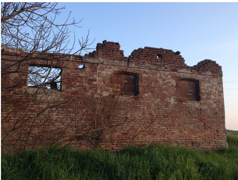
Figura 4.5: Particolare del prospetto Nord del fienile.
