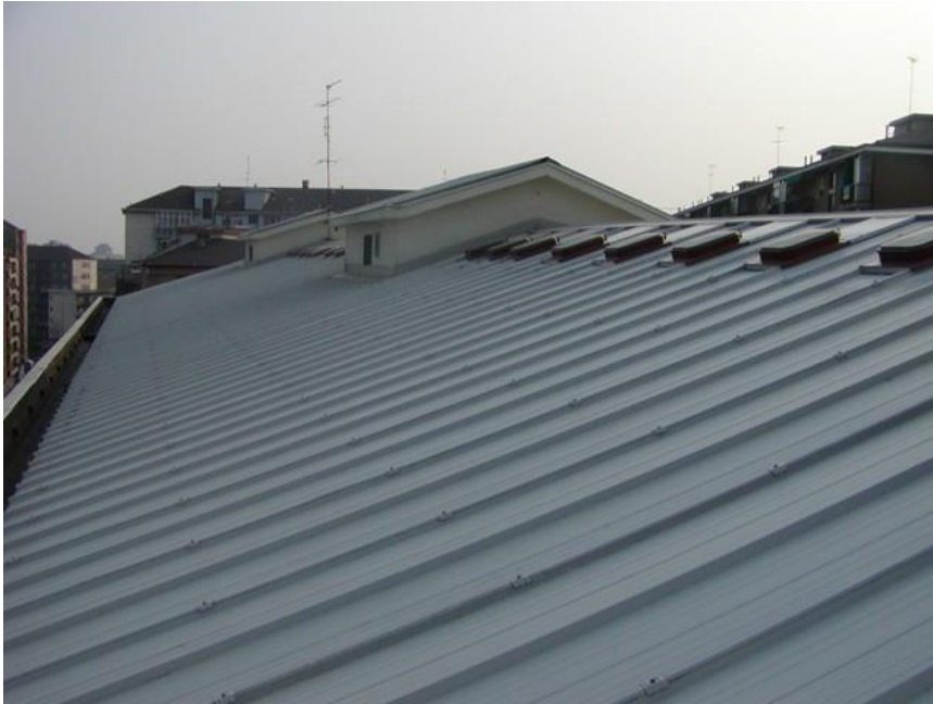
Figura 5.5: Esempio di una copertura in pannelli coibentati.
