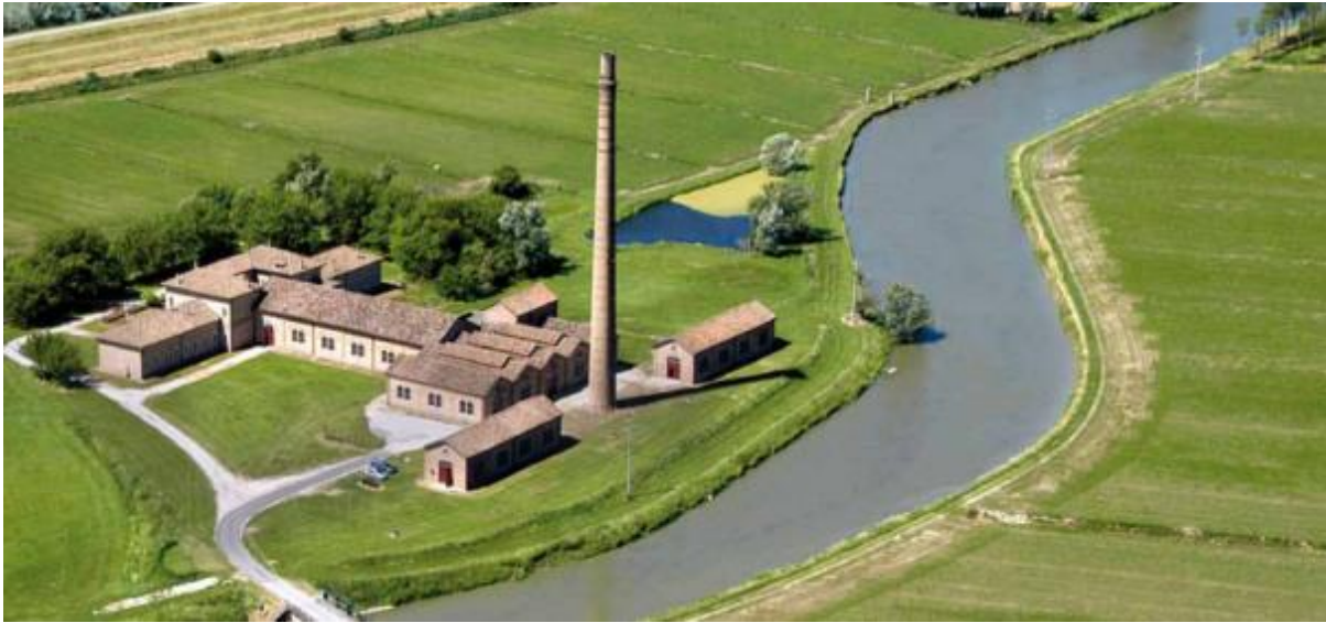
Figura 1.5: Foto aerea dell'ex Idrovora di Cà Vendramin.
