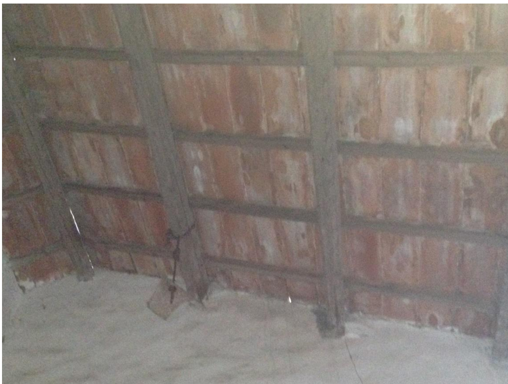
Figura 4.13: Copertura in legno e tavelle.
