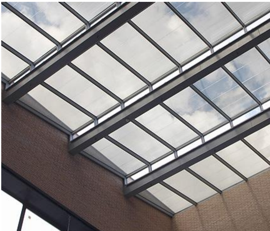
Figura 5.4: Esempio di una copertura in vetro fotovoltaico.
