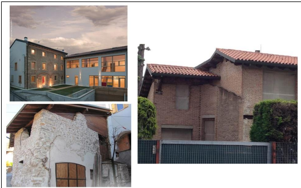
Figura 5.3: Esempi di restauro conservativo. A destra, un progetto simile a quello che si ha intenzione di eseguire per questa tesi.
