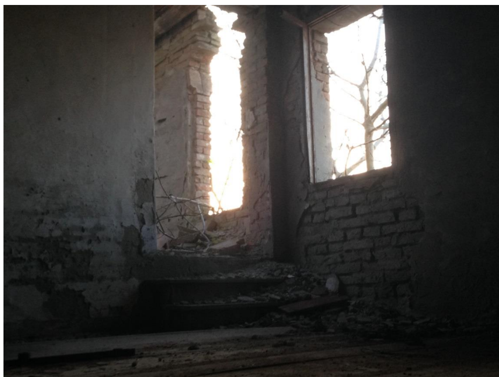
Figura 4.12: Scalini che permettevano l'accesso al granaio.
