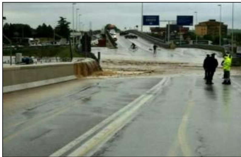
Figura 16. Fasi di allagamento della Strada Regionale 11 nel 2013 nei pressi della confluenza Alpone-Tramigna (immagine da fanpage.it).
