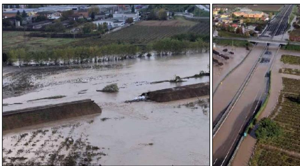
Figura 14. Dettagli delle rotte arginale dell'Alpone e dell'Autostrada MI-VE nel 2010 (Regione Veneto 2010).
