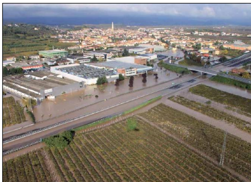
Figura11. Dettaglio degli effetti dell'alluvione (Regione Veneto 2010).
