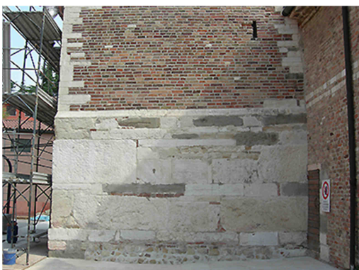
Fig. 1.1.2 – Zoccolo torre – lato ovest.
