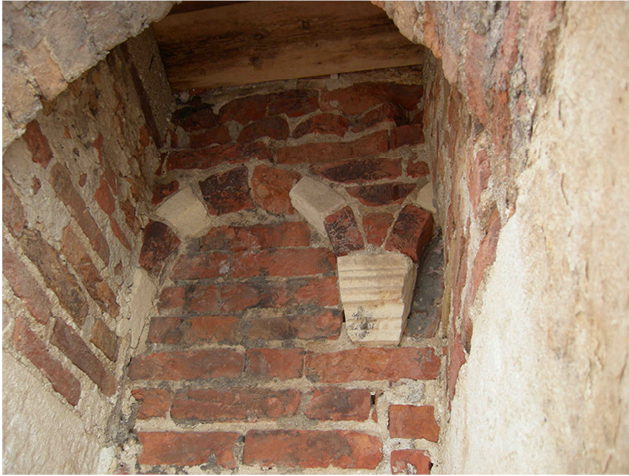
Fig.A.4.5 – Particolare archi decorativi fascia sotto cella campanaria.
