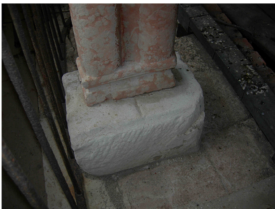
Fig.A.3.10 – Particolare colonna ovest – basamento.
