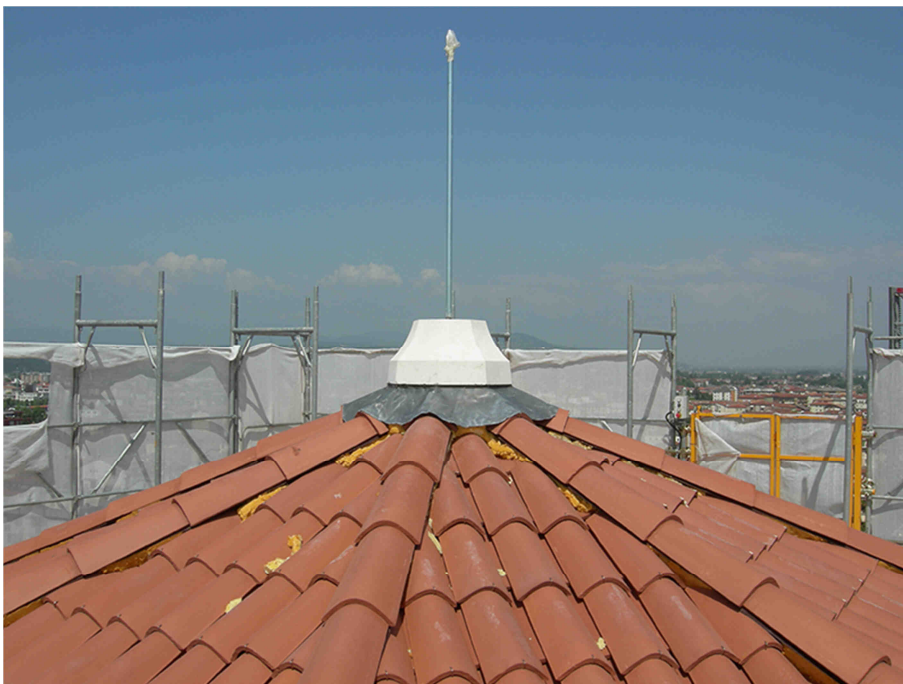
Fig.A.1.5 – Copertura: vista esterna della pietra di sommità e del manto di copertura in coppi.
