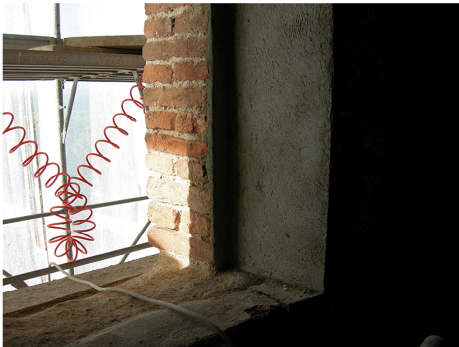
Fig.A.2.6 – Particolare seconda apertura dall'alto – lato sud: si coglie la stratigrafia della muratura.
