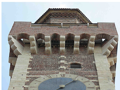
Fig. 1.1.6 – Vista della merlatura – lato ovest.
