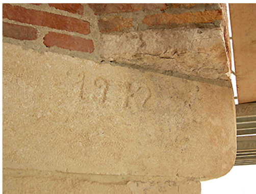
Fig. 1.1.16 – Modiglioni sostituiti dopo il crollo
