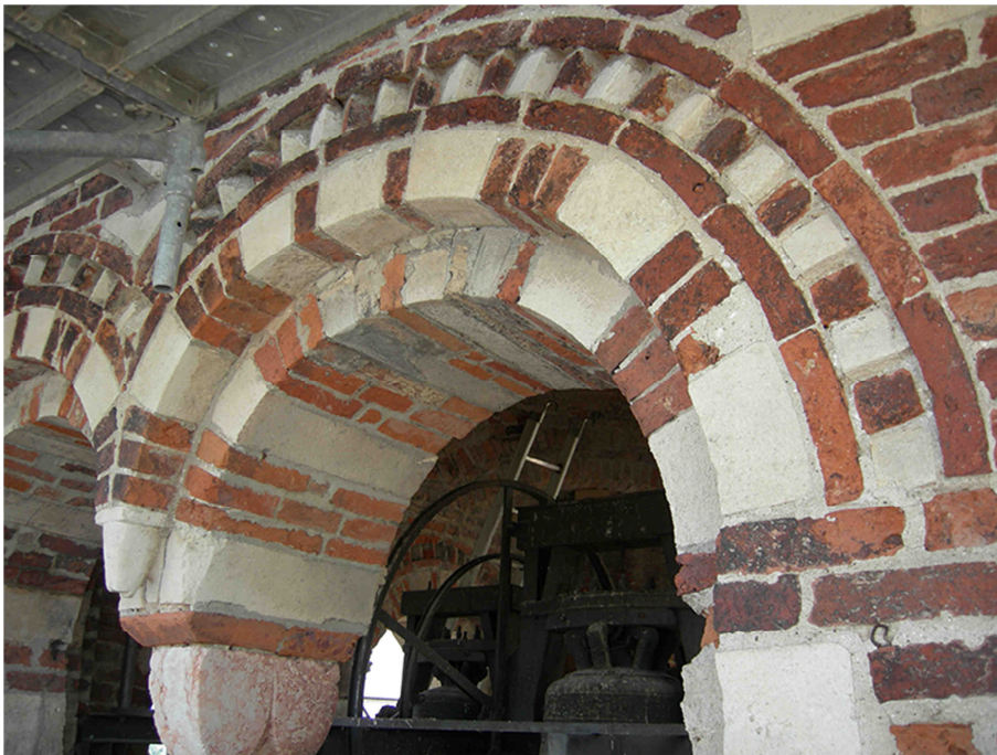
Fig.A.3.8 – Particolare esterno d'insieme arco ovest – zona bifore.
