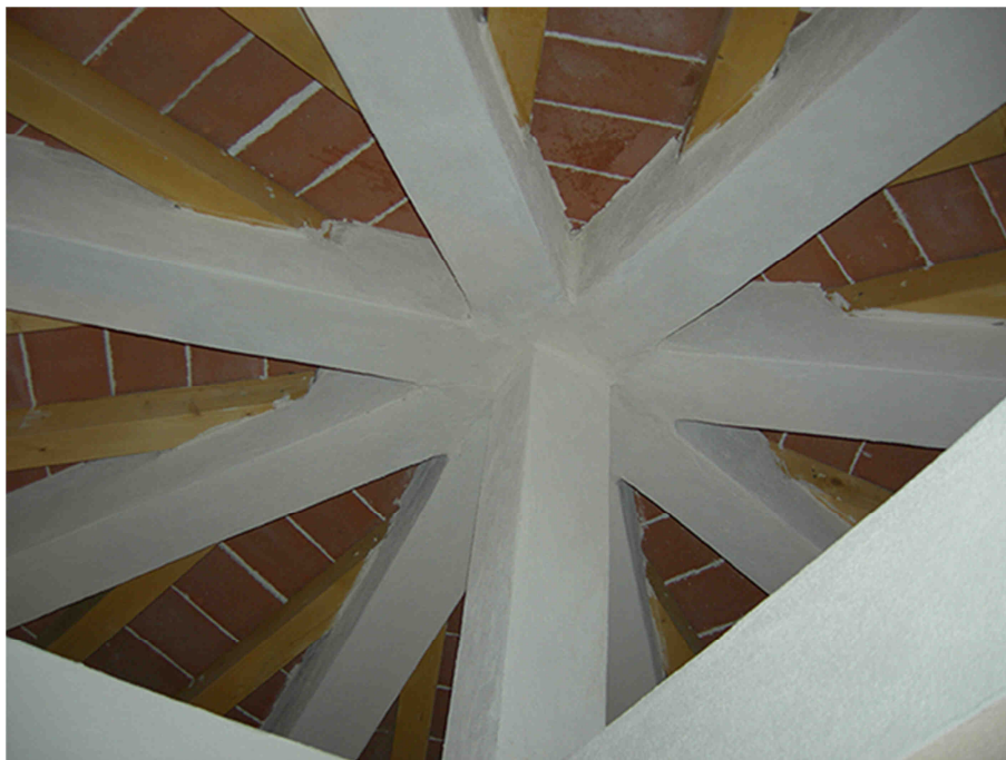
Fig. A.1.1 – Particolare incrocio travi della crociera dopo il rifacimento della copertura.
