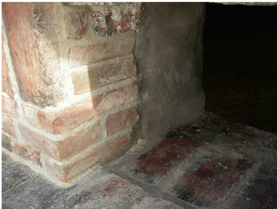
Fig.A.2.4 – Particolare prima apertura dall'alto su decorazione – lato sud: si coglie la stratigrafia della muratura.
