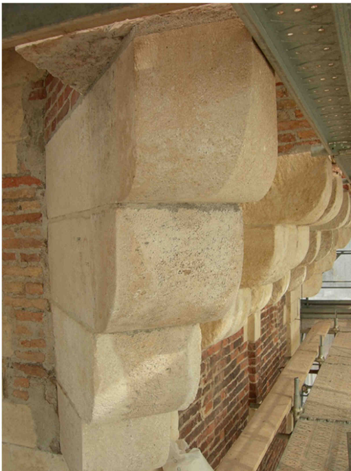
Fig.A.4.6-7 - Vista degli ordini di mensole d'angolo e di facciata.
