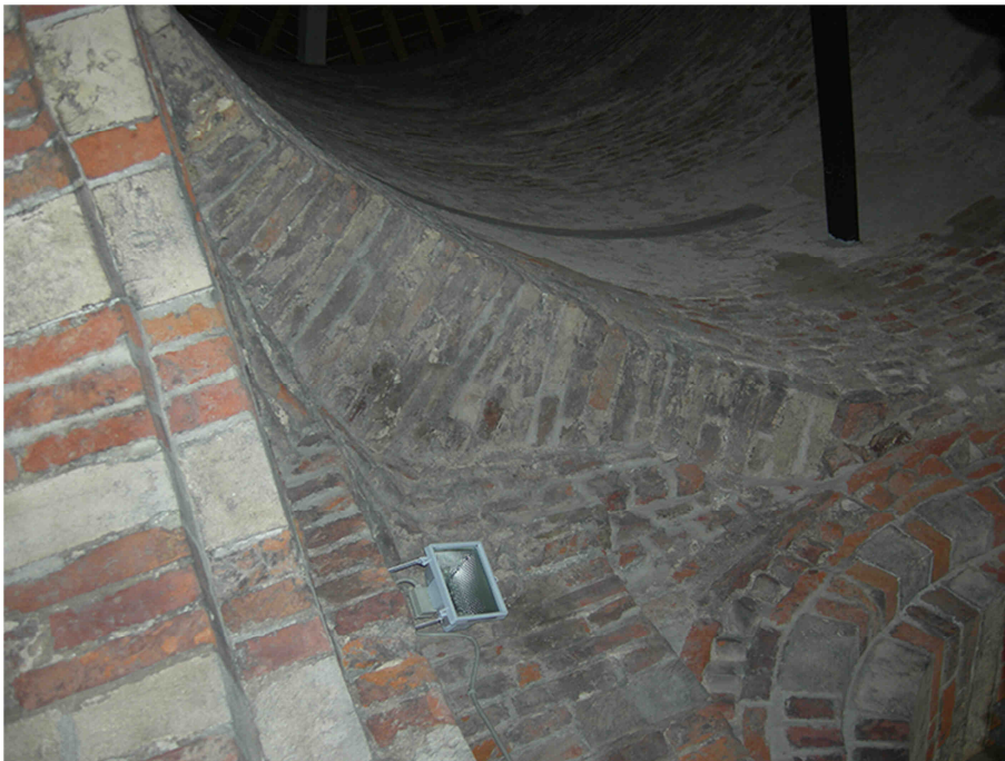
Fig.A.3.28 – Particolare archi di scarico laterali – angolo nord ovest – vista dal basso.
