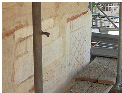
Fig. 1.1.3 – Dettaglio zoccolo – lato nord.
