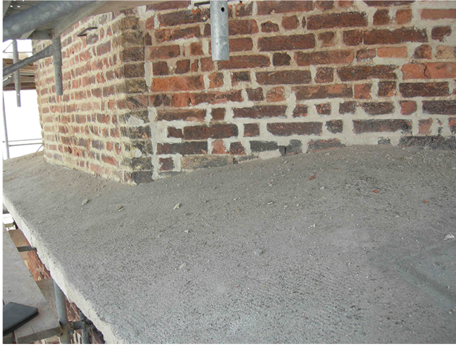
Fig.A.2.7 – Particolare innesto tamburo su cella campanaria: vista esterna.
