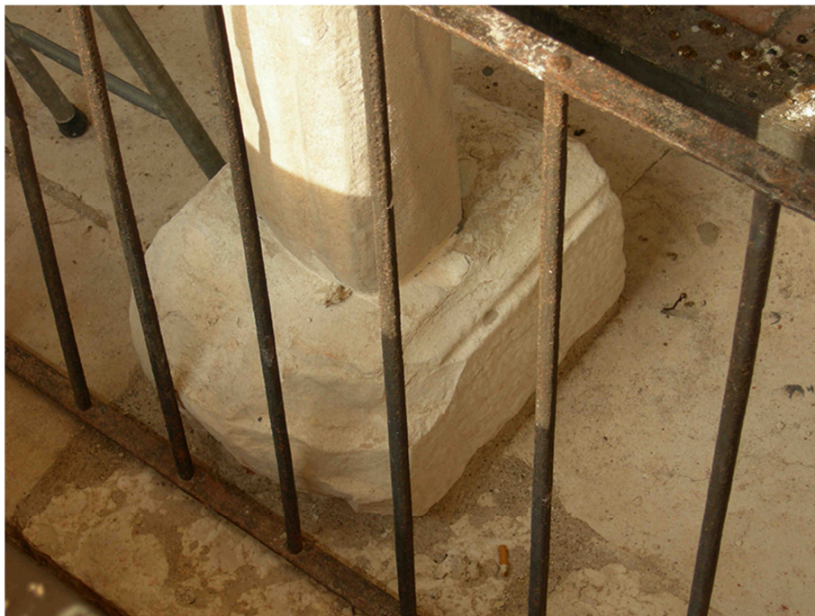
Fig.A.3.13 – Particolare colonna est – basamento.
