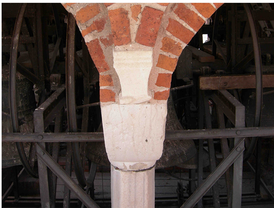
Fig.A.3.14 – Particolare colonna est – vista frontale capitello.
