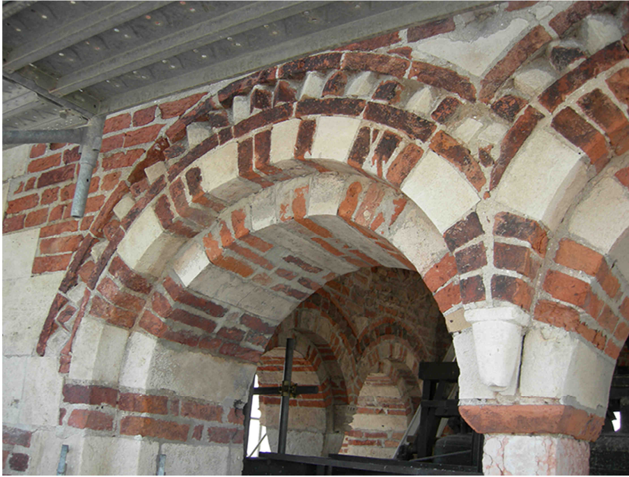
Fig.A.3.7 – Particolare esterno d'insieme arco ovest – zona bifore.
