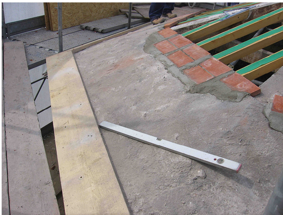
Fig.A.1.10 – Particolare copertura in ricostruzione: manto di tavelline e guaina sui morali in legno.
