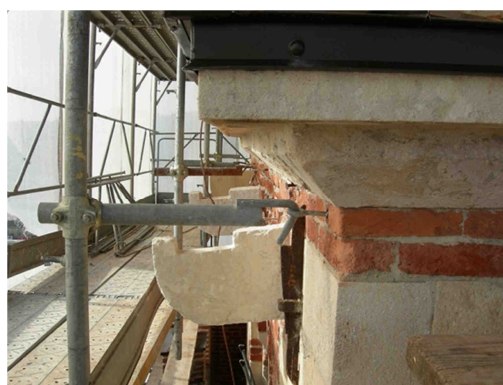
Fig. 1.1.22 – Capo chiave e cornicione.
