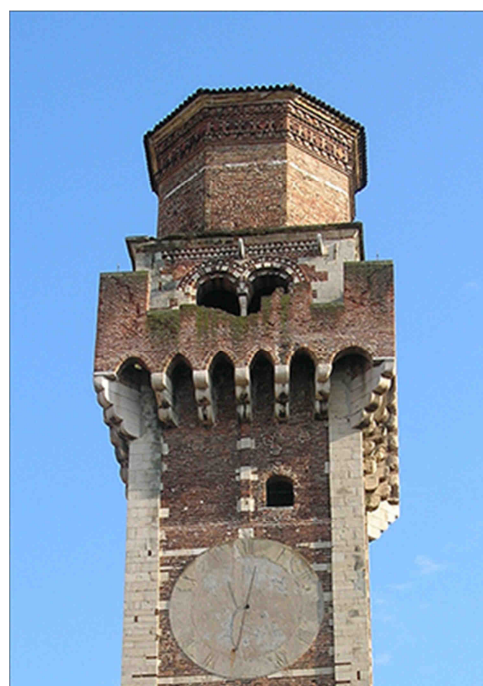
Fig. 1.1.1 – Torre campanaria – lato ovest.
