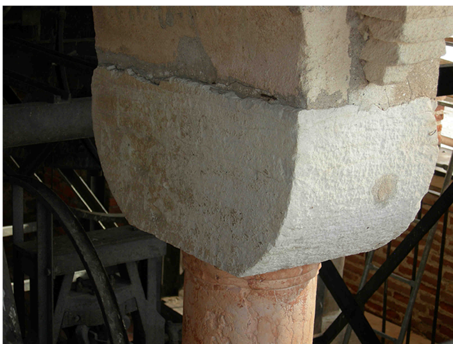
Fig.A.3.18 – Particolare colonna sud – capitello.
