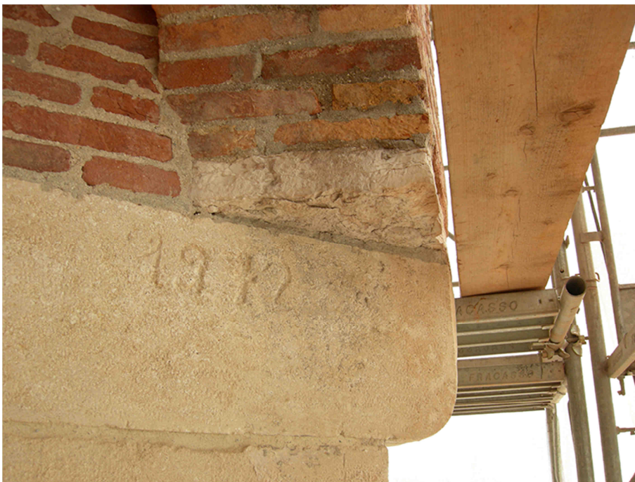
Fig.A.4.4 – Particolare mensole d’angolo. Si noti l’incisione 1972, anno del restauro a seguito del crollo dei modiglione nord-est.
