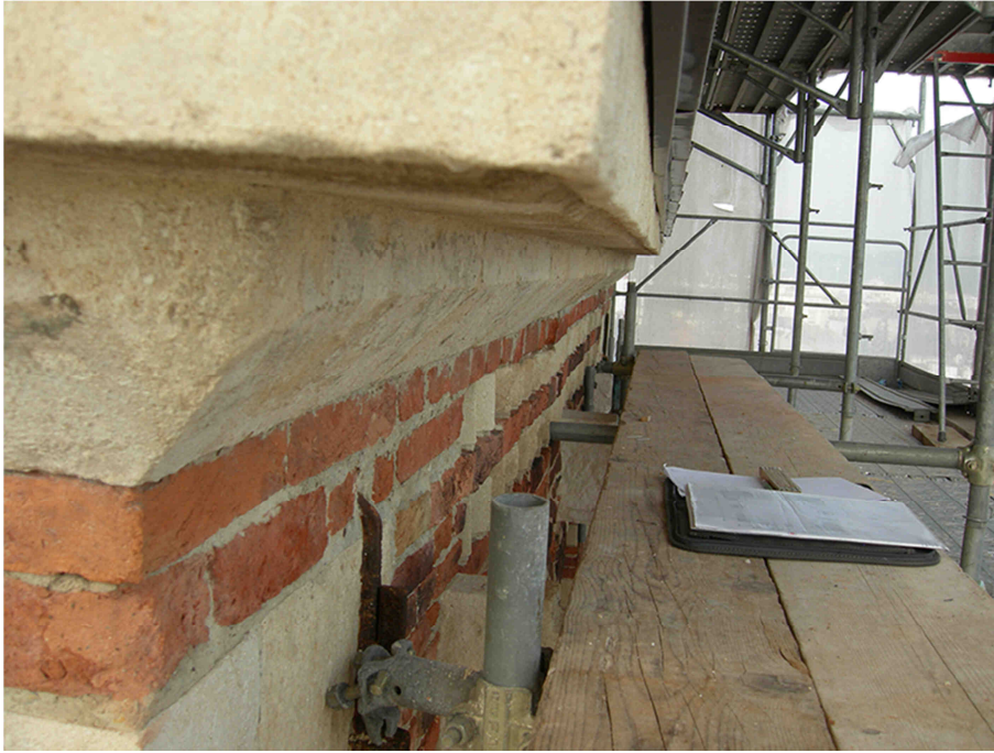
Fig.A.3.23 – Particolare profilo cornice in pietra cella campanaria.
