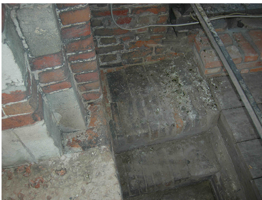
Fig.A.3.32 – Smonto scala interna su piano cella campanaria – angolo sud ovest.
