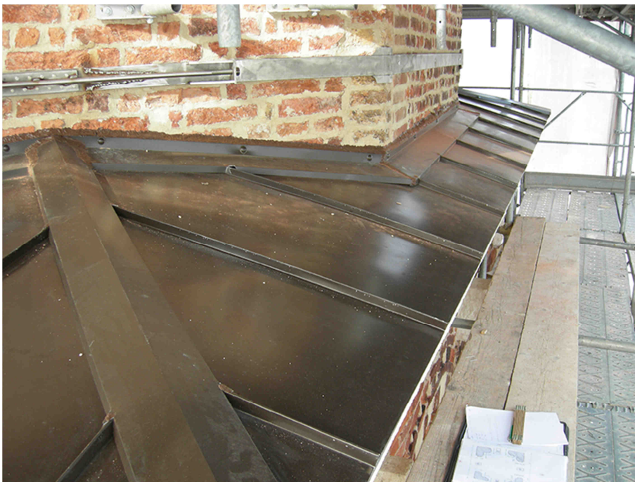
Fig.A.3.22 – Particolare copertura in lamiera della cornice cella campanaria.
