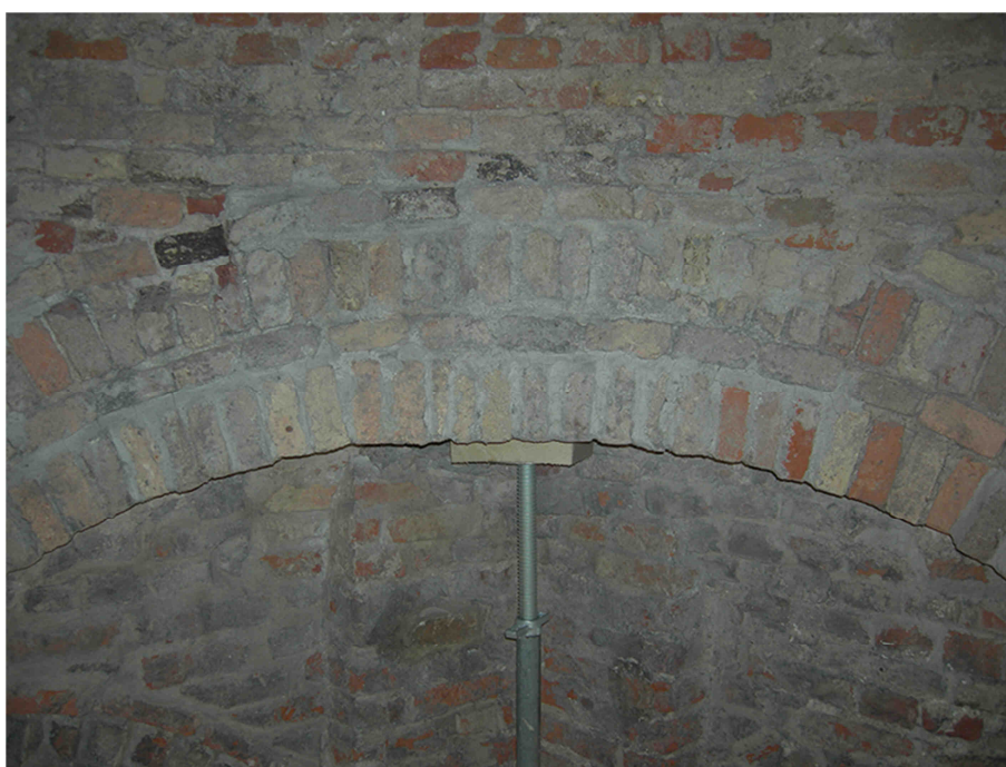
Fig.A.3.26 – Particolare archi di scarico laterali – angolo nord est.
