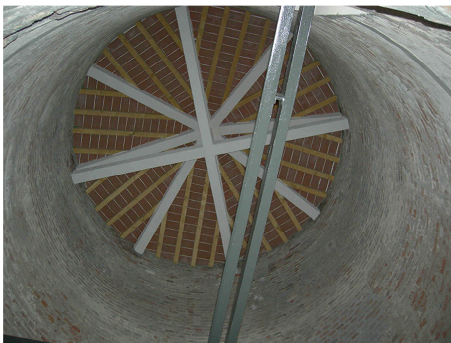
Fig.A.1.9 – Copertura dalla base cella campanaria alla fine dei lavori interni al fusto.
