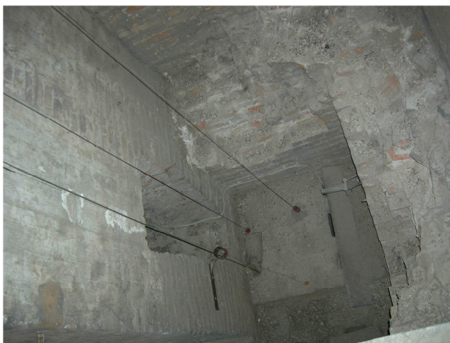
Fig.A.6.14 – Particolare base cisterna d'acqua al piano sottostante la cella campanaria.
