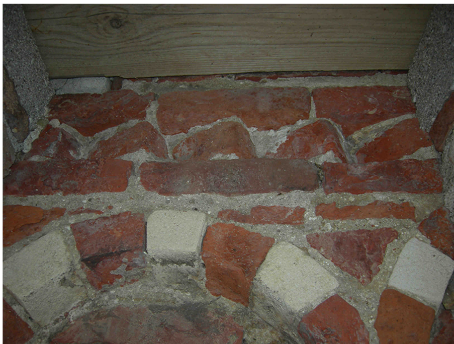
Fig.A.4.16 – Particolare decorazioni degli archi decorativi fascia sotto cella campanaria..
