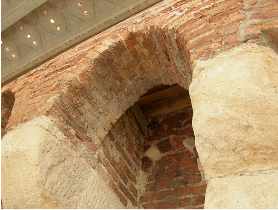
Fig.A.4.3 – Particolare dell’arco tra le mensole in pietra reggi merlatura.
