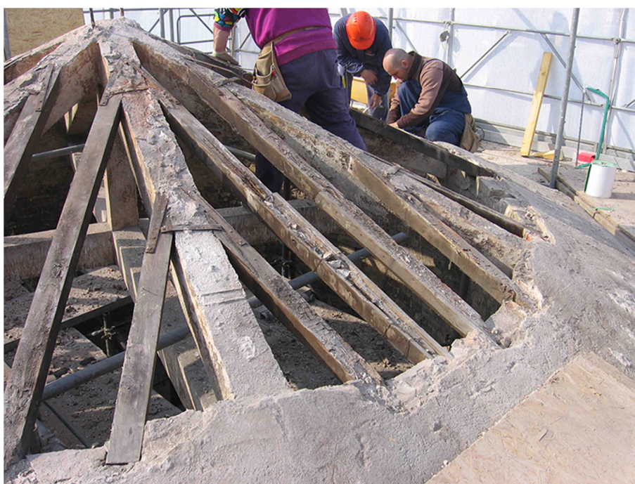
Fig.A.1.11 – Copertura scoperchiata per l'intervento di consolidamento e ripristino.
