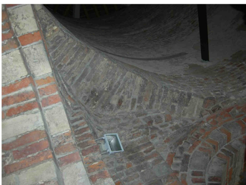
Fig. 1.1.23 – Archi di scarico.
