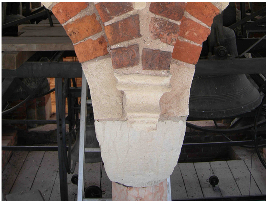
Fig.A.3.17 – Particolare colonna nord – vista frontale capitello.
