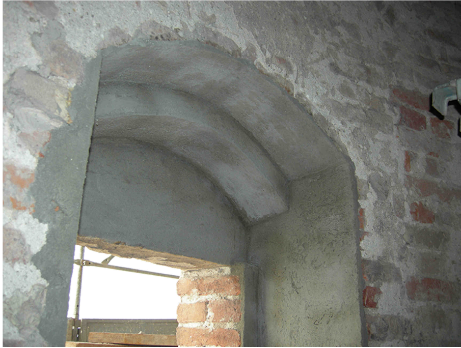
Fig.A.2.5 – Particolare seconda apertura dall'alto – lato sud.
