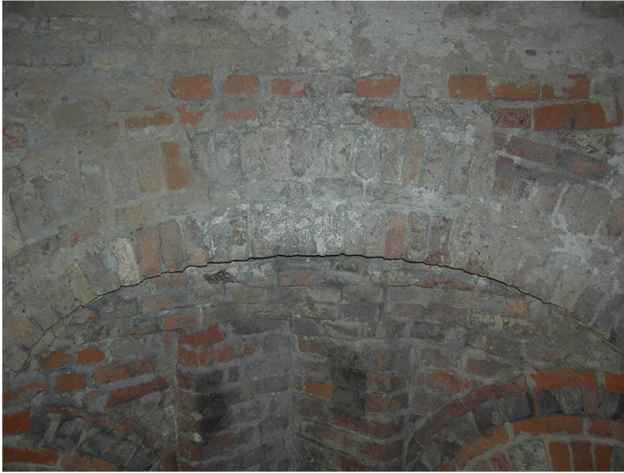
Fig.A.3.27 – Particolare archi di scarico laterali – angolo sud est.
