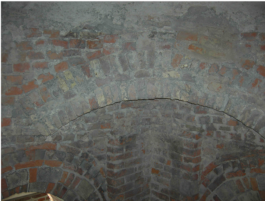
Fig.A.3.24 – Particolare archi di scarico laterali – angolo sud ovest.
