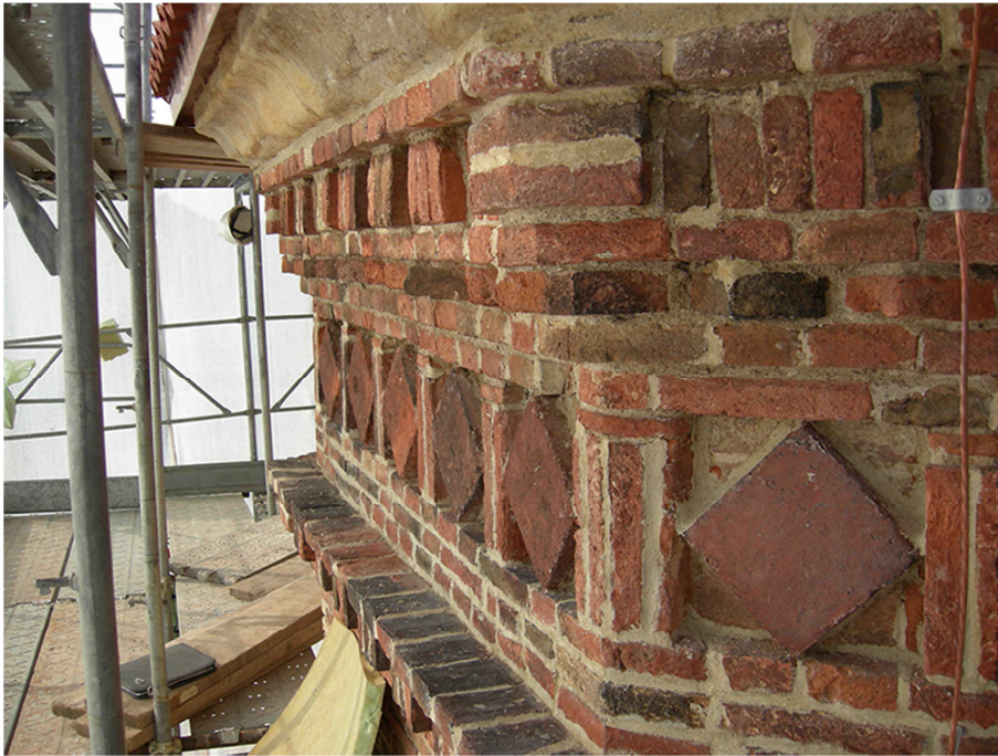
Fig.A.2.1 – Particolare decorazioni tamburo appena sotto la cornice in pietra della copertura.
