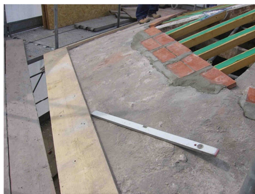
Fig. 1.1.26 – Estensione del manto di tavelline.
