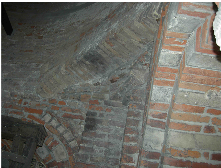
Fig.A.3.29 – Particolare archi di scarico laterali – angolo nord est – vista dal basso.
