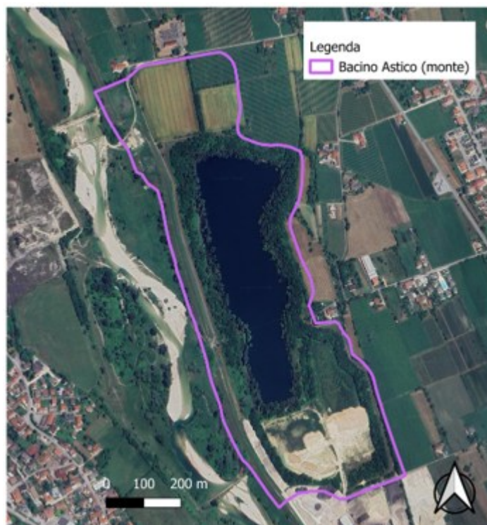
Figura 42 – Panoramica area attuale dell'area adibita al bacino di monte sul torrente Astico (Elaborazione Qgis).
