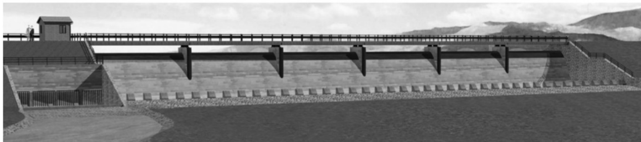
Figura 17 - Vista dalla cassa di valle dell'opera di collegamento del bacino di monte con quello di valle (Regione del Veneto, 2012).
