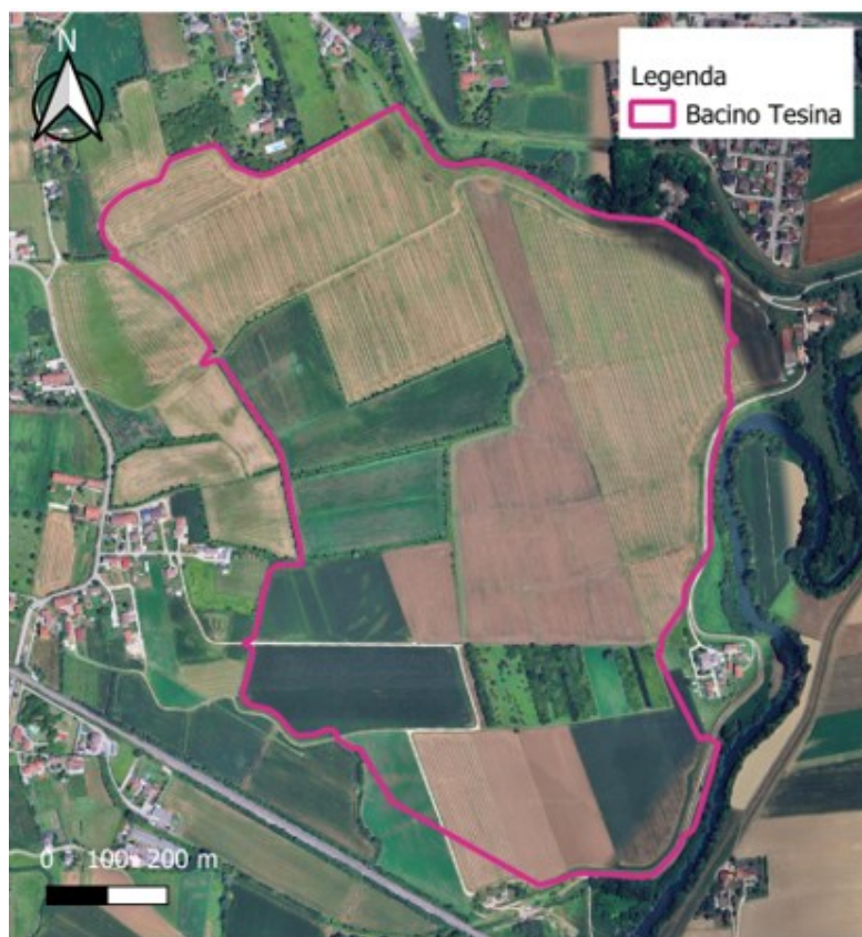
Figura 47 – Panoramica aerea attuale dell'area da destinare a bacino sul fiume Tesina (Elaborazione con Qgis).
