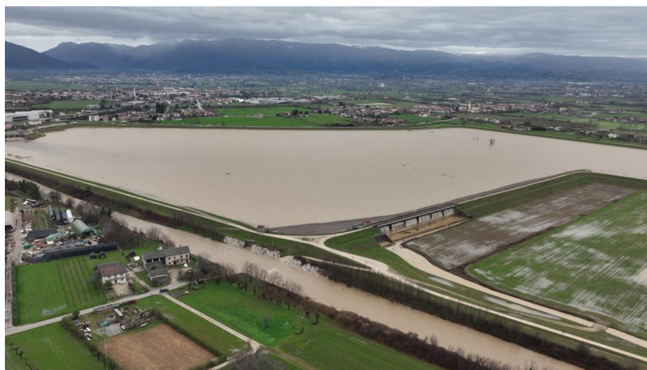
Figura 15 - Bacino di Laminazione a Caldogno nella provincia di Vicenza.
