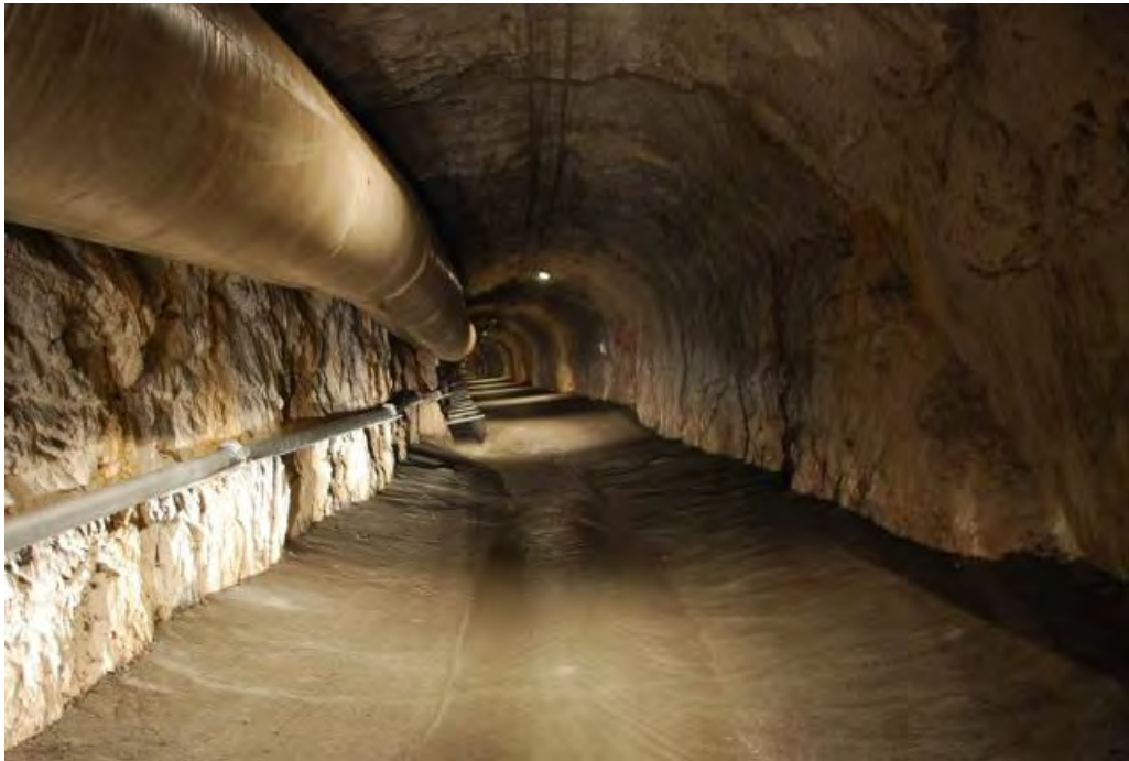
Figura 1.19 - L'interno della galleria drenante (internet, www.iqtconsulting.it )
