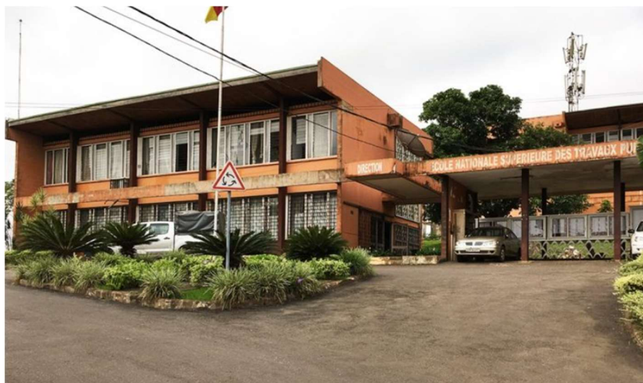
Figure 12 : Direction école nationale supérieure des travaux publics (CAMERPRESS, 2020)
