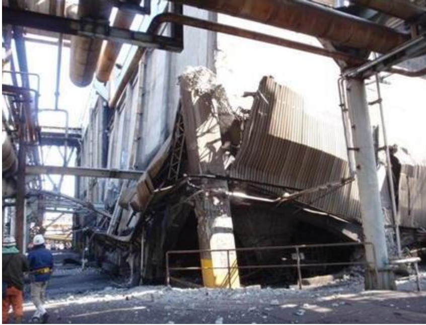
Figura 1.5. Resti del forno dell'acciaieria di Kashima in seguito al terremoto di Tohoku del 2010 (Krausmann et al. (2013)).
