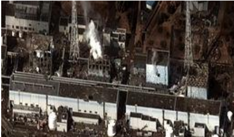
Figura 1.2. Centrale nucleare di Fukushima dopo l'incidente dell'11/03/2011
