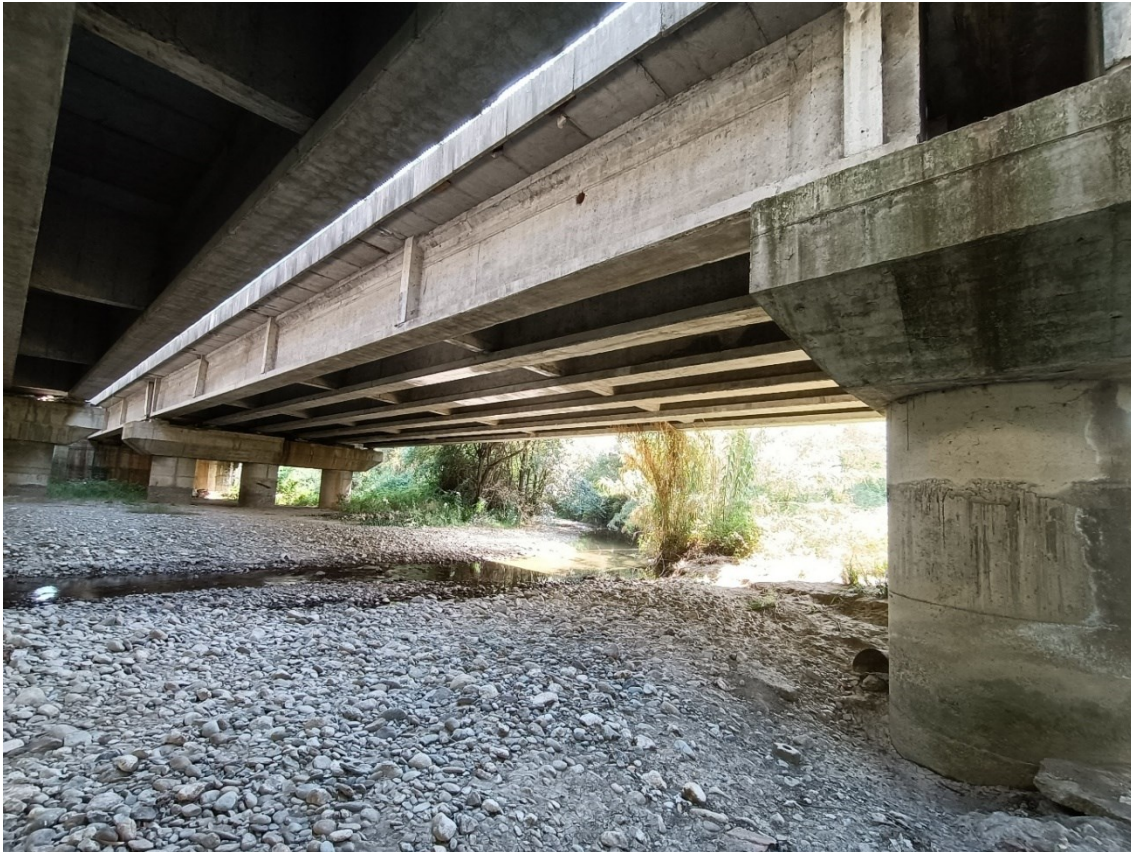
Figura 3-3 Ponte sul torrente Mavigliano (carreggiata Sud), inquadramento generale dell'opera
