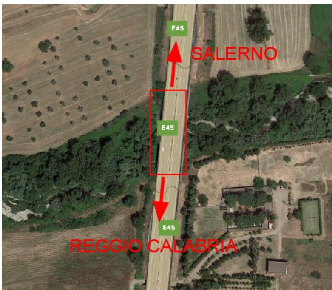
Figura 3-1 Ponte sul torrente Mavigliano (carreggiata Sud), foto aerea
