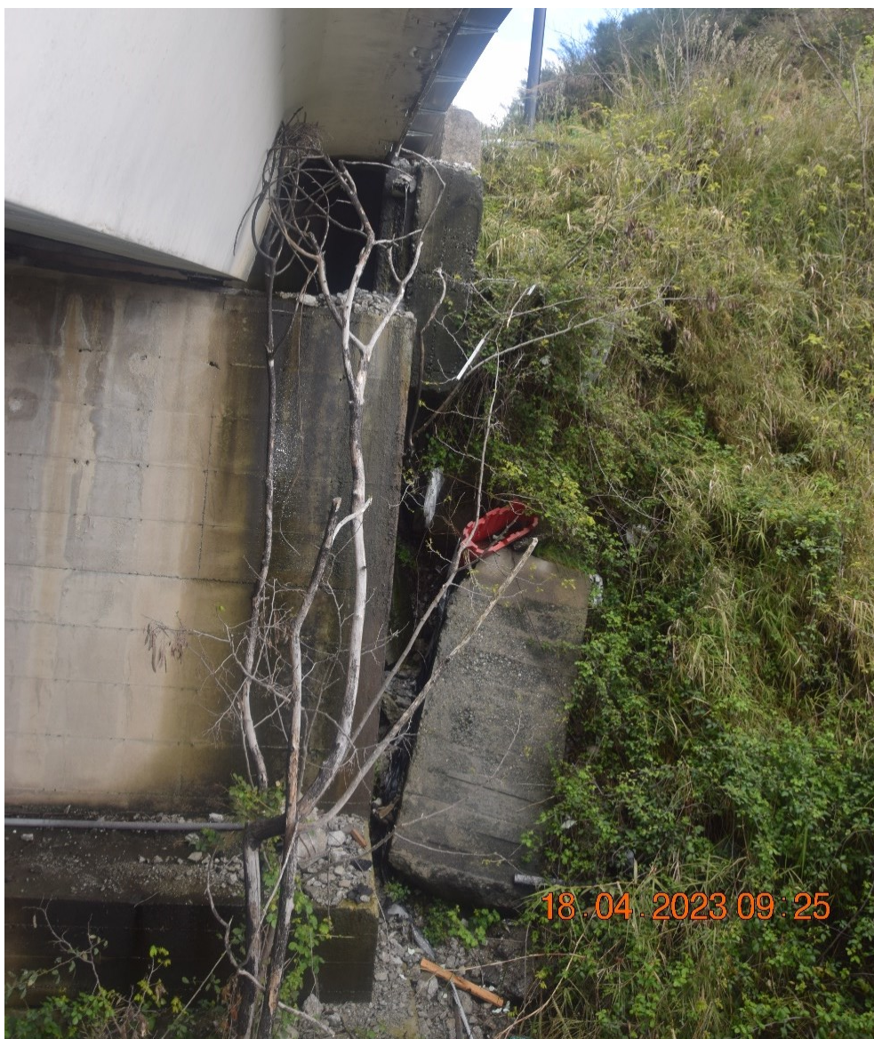
Figura 2-17 Viadotto Valle Vomice, spalla - porzione di muro andatore crollata
