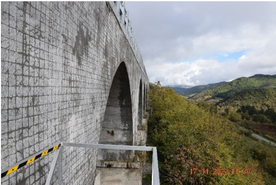
Figura 2-13 Viadotto Coda del Savuto, arco in c.a.
