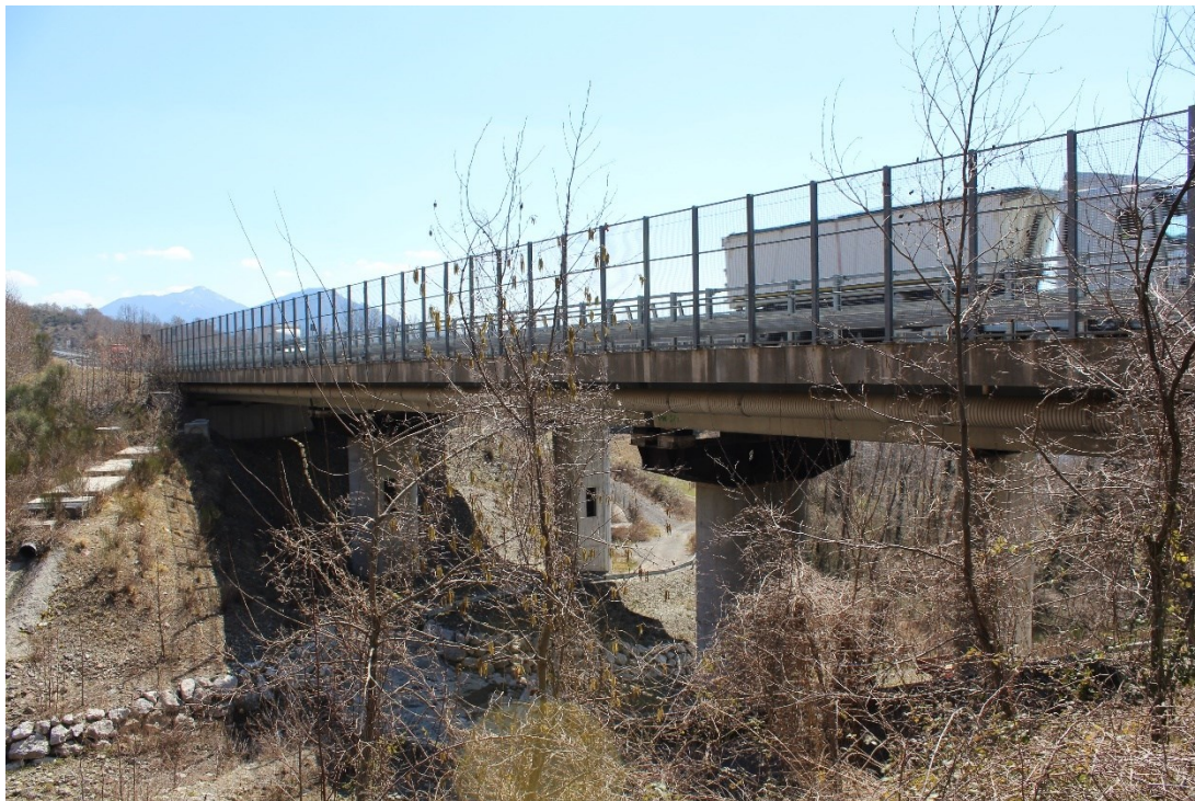
Figura 2-10 Viadotto Paccioni, su discontinuità orografica + corso d'acqua
