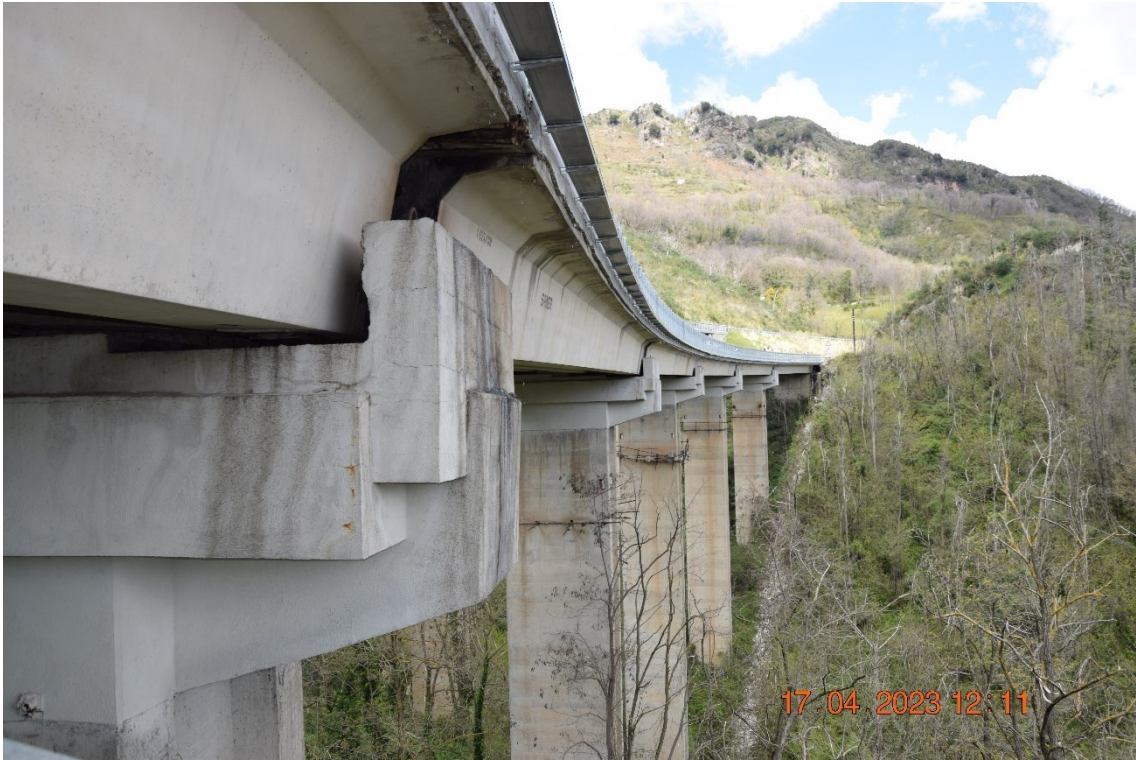
Figura 2-12 Viadotto Valle Vomice, travate appoggiate
