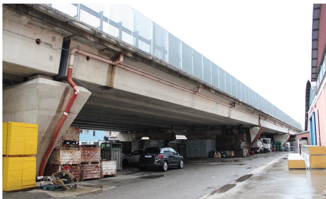
Figura 2-11 Viadotto Fornace, su zona edificata
