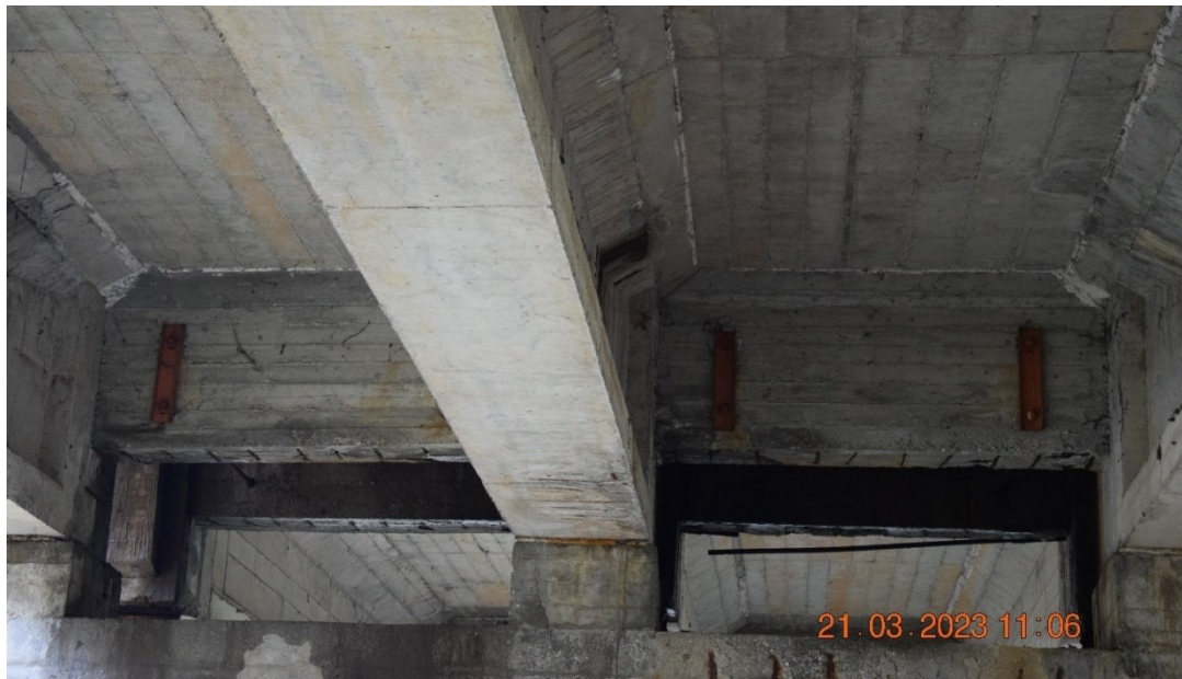
Figura 2-15 Viadotto Fosso Silicara, traverso - ferro longitudinale sospeso
