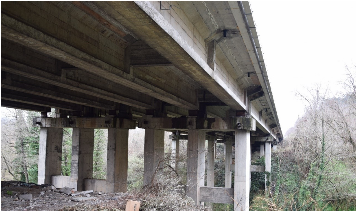
Figura 2-8 Viadotto Fosso Silicara, anno di costruzione 1969 (no lavori di ammodernamento)
