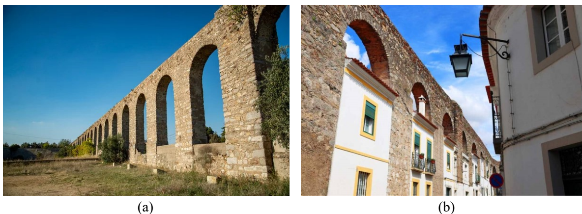
Fig. 4.1.4: a) Acquedotto Prata ad Évora 117 ; b) occupazione degli archi dell'acquedotto dalle case 118 .
