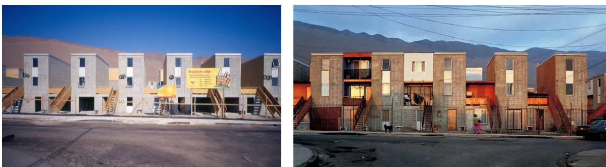
(a) (b) Fig. 4.2.2: a) Quinta Monroy appena costruita 129 ; b) Quinta Monroy valorizzata dall'autocostruzione 130 .
