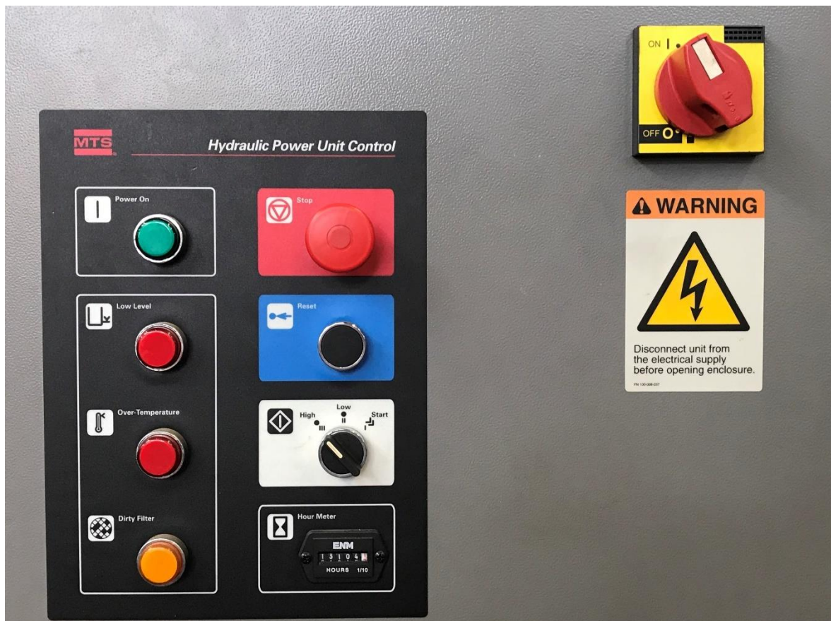
Figura 3.19: pannello di controllo del gruppo pompe relativo al banco biassiale.
