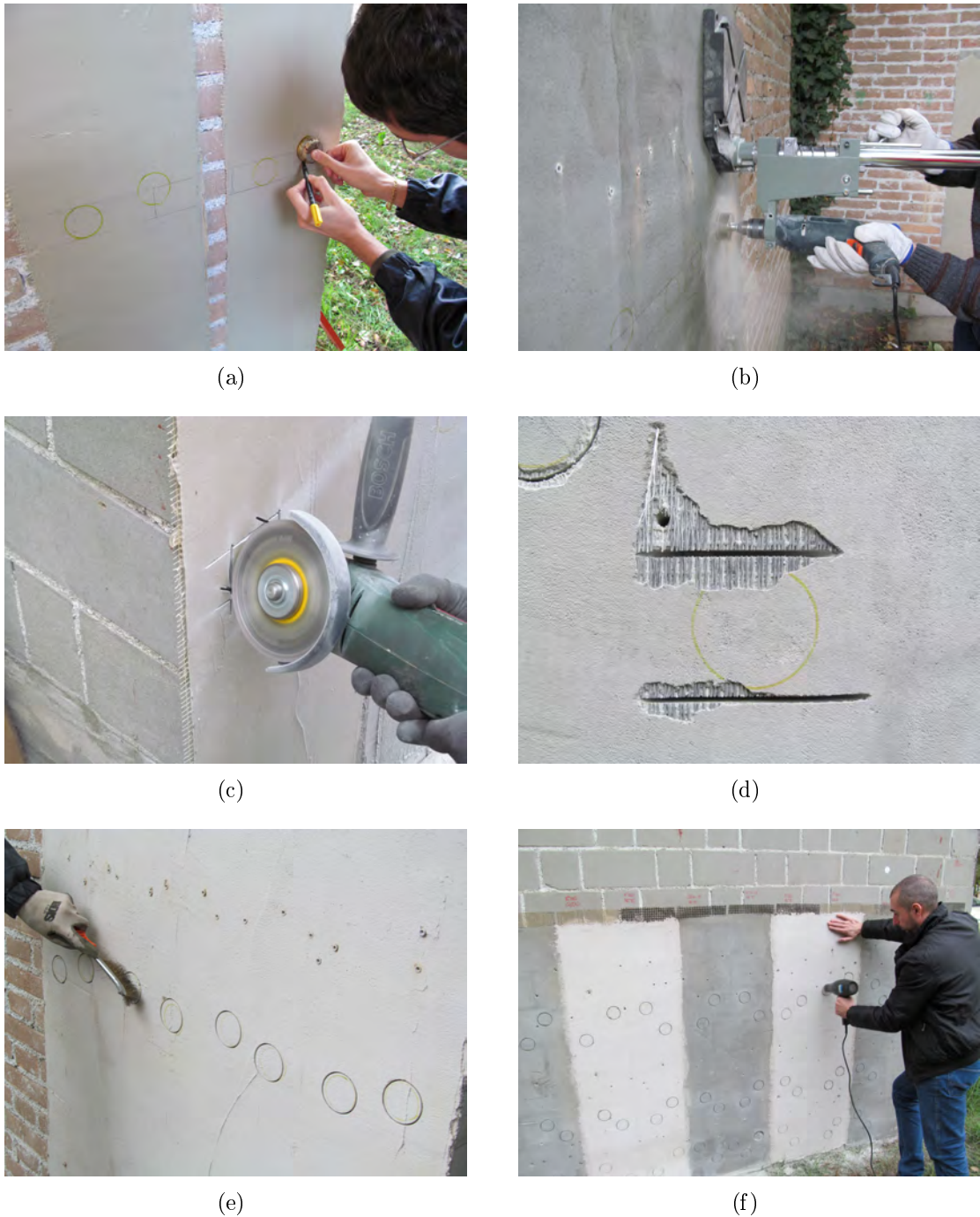
Figura 3.14: Procedura di preparazione dei provini per pull-off: disegno circonferenze (a), esecuzione taglio con tazza diamantata su trapano “a colonna” (b), esecuzione taglio con flessibile (c), dettaglio del distacco matrice superficiale nei compositi G2000_Geolite (d), spazzolatura pannello (e), asciugatura pannello (f)
