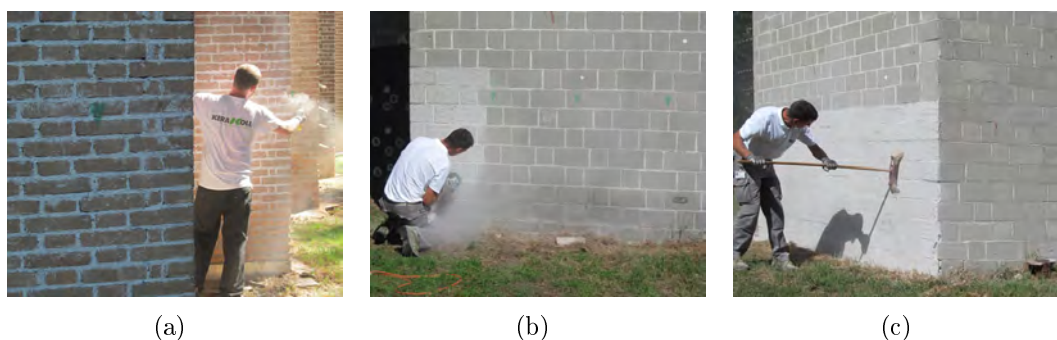
Figura 3.10: Preparazione pannelli per l'applicazione dei compositi
