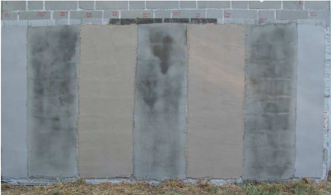
Figura 3.12: Pannello A5L (muratura in pietra) alla fine dell'applicazione dei compositi
