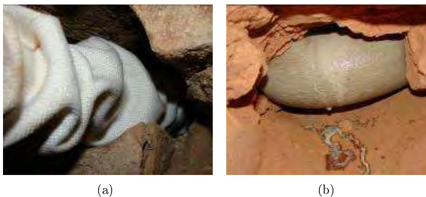
Figura 2.54: Fasi di iniezione delle calze nei fori della muratura (Algeri e altri , 2010)
