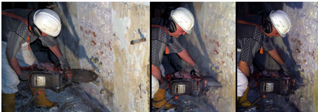
Figura 1.16: Taglio con mototroncatrice a disco diamantato eccentrico
