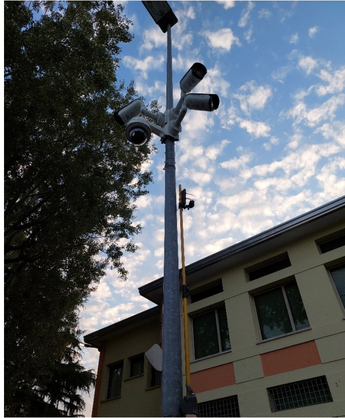
Figura 33: Esempio di posizionamento di videocamera di tipo "A" su palo telescopico
