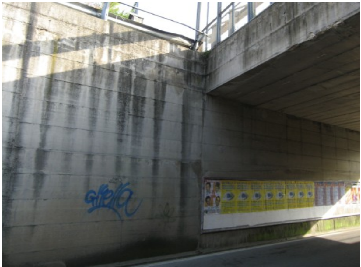
Figura 61 - Particolare della spalla del ponte
