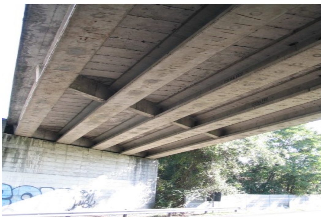
Figura 112 - Particolare della spalla e della parte inferiore di uno dei due impalcati
