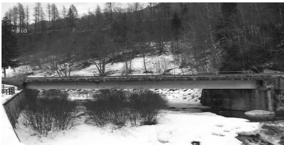
Figura 503 - Foto del ponte "Torrente Maè I"
