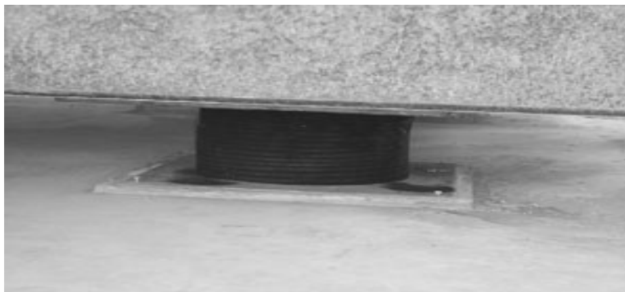
Figura 155 - Esempio di appoggio cilindrico in neoprene armato in condizioni di esercizio
