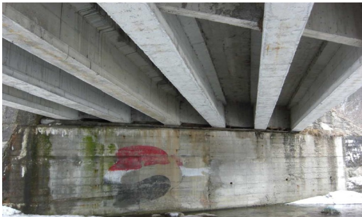
Figura 82 - Particolare della spalla e della parte inferiore dell'impalcato
