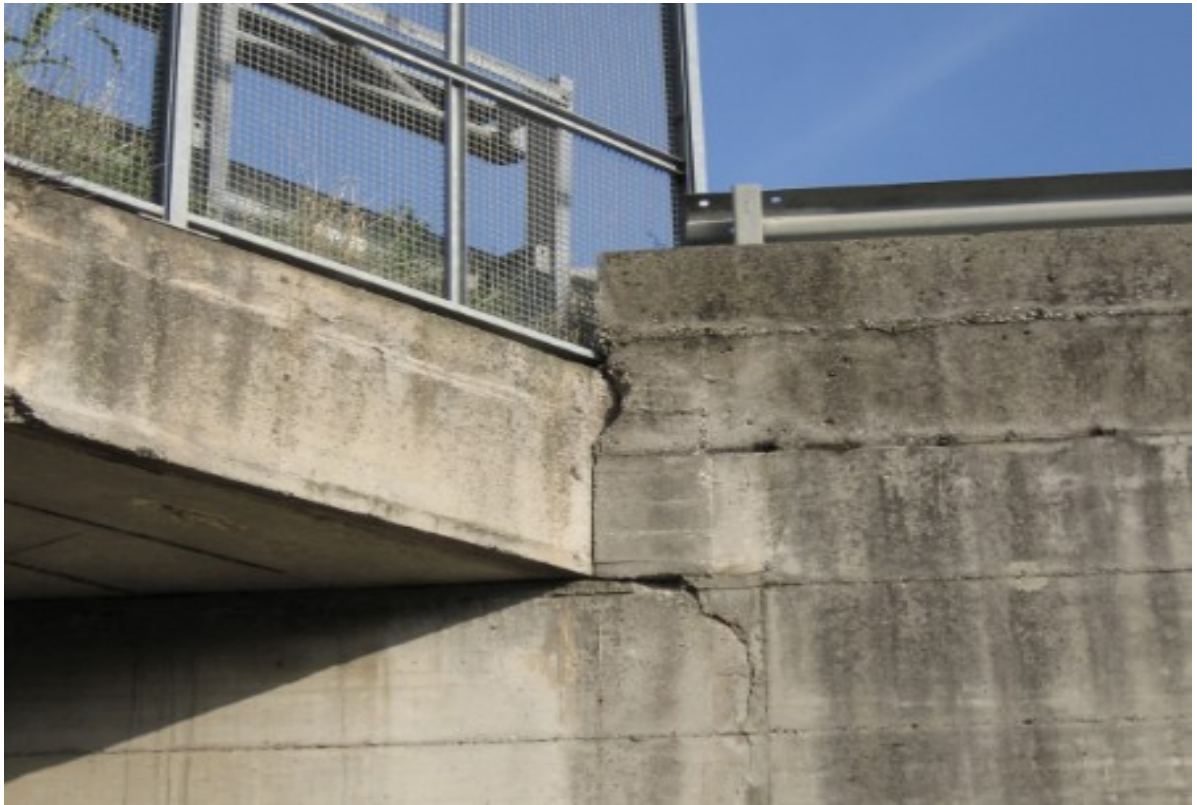
Figura 60 - Particolare della connessione spalle-appoggio
