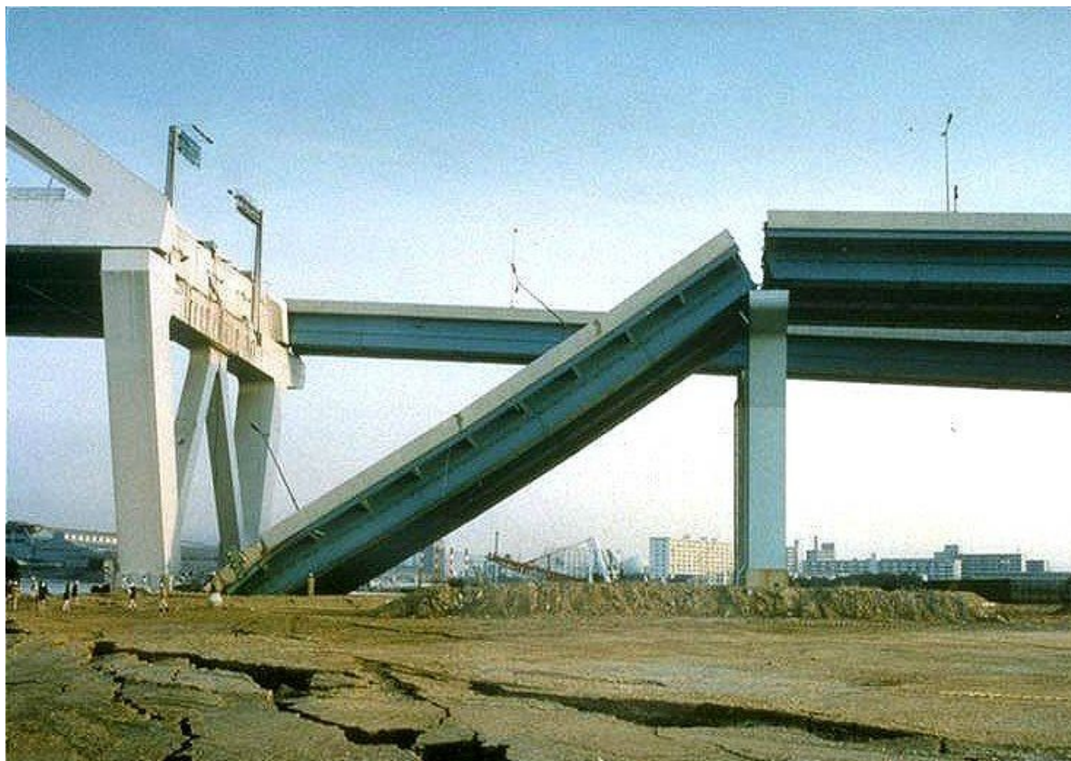
Figura 1 - Danni su un ponte dopo un evento sismico
