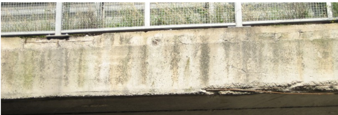
Figura 59 - Particolare della struttura a solettone del ponte
