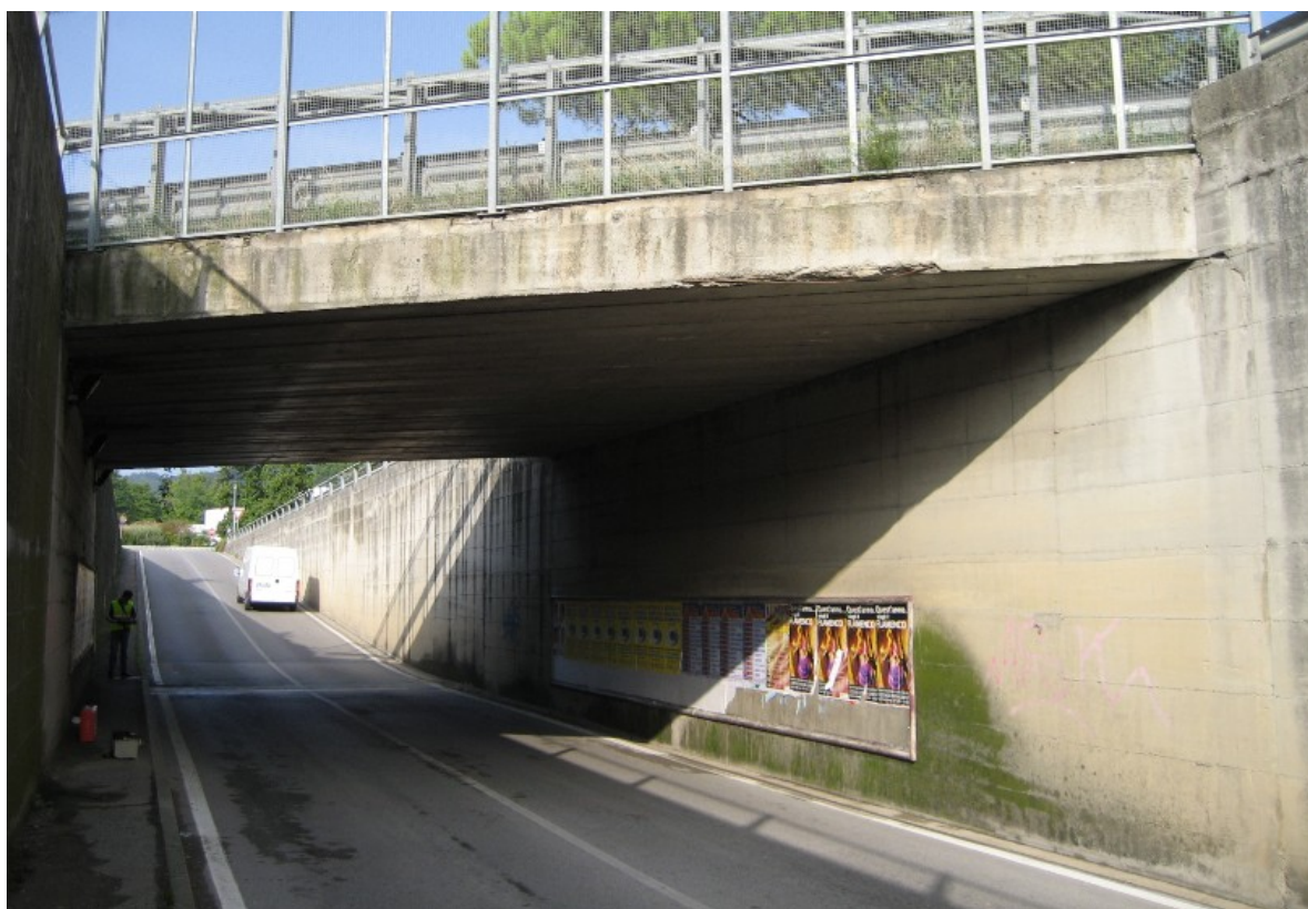
Figura 58 - Visione d'insieme del ponte
