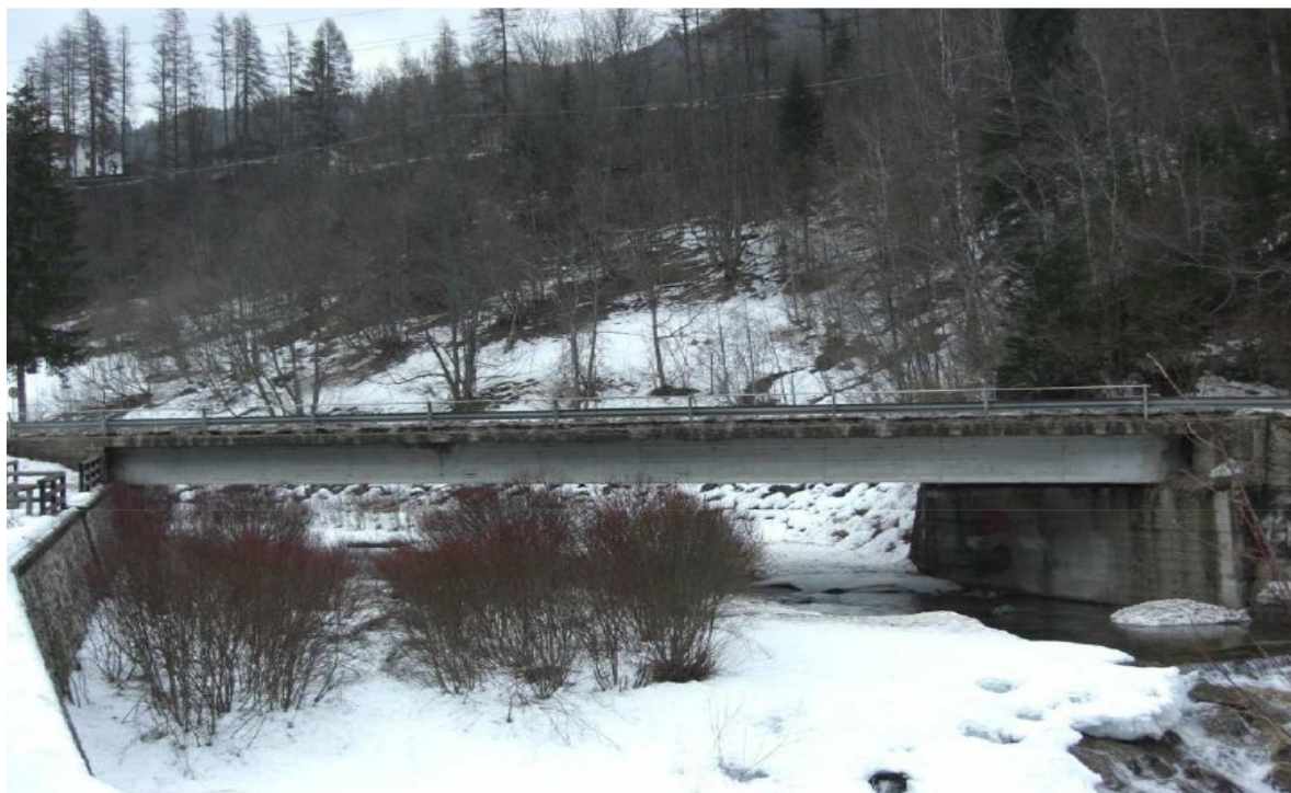
Figura 81 - Visione generale del ponte
