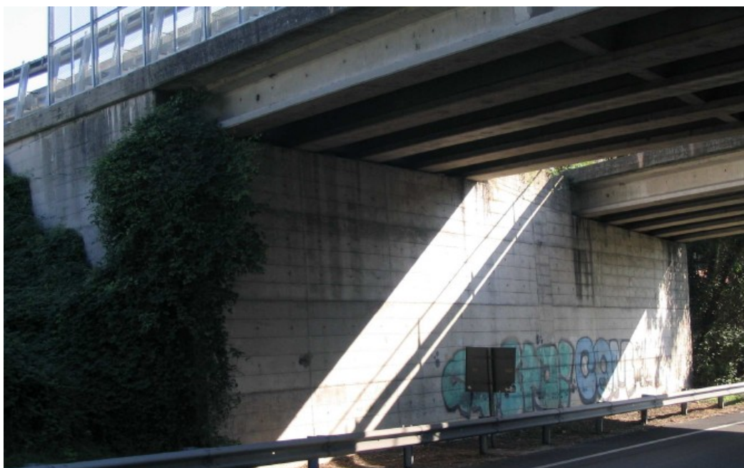
Figura 111 - Visione generale del ponte
