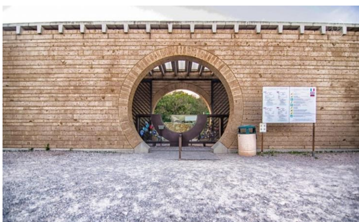
Fig 21 M. Botta, Ingresso per Il Giardino dei Tarocchi , 1997.
